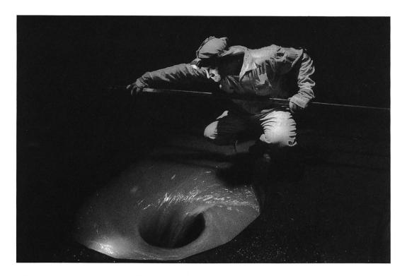
Abb. 4 Inspektion eines Wirbelfallschachtes.
