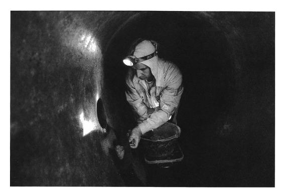
Abb. 5 Maurer bei Unterhaltsarbeiten in einem Kanal.
