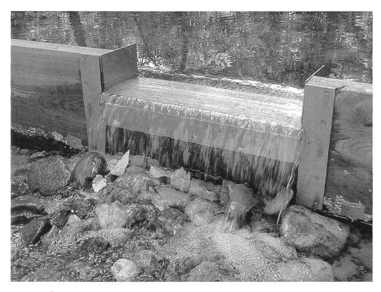
Abb. 3 Über dieses Einleitungsbauwerk fliesst das Birswasser aus dem Teichbächlein in das Pflanzenklärgebiet hinein. Ein Absetzbecken für die Sedimente ist nicht vorhanden. (Aufnahme Mai 2003)
