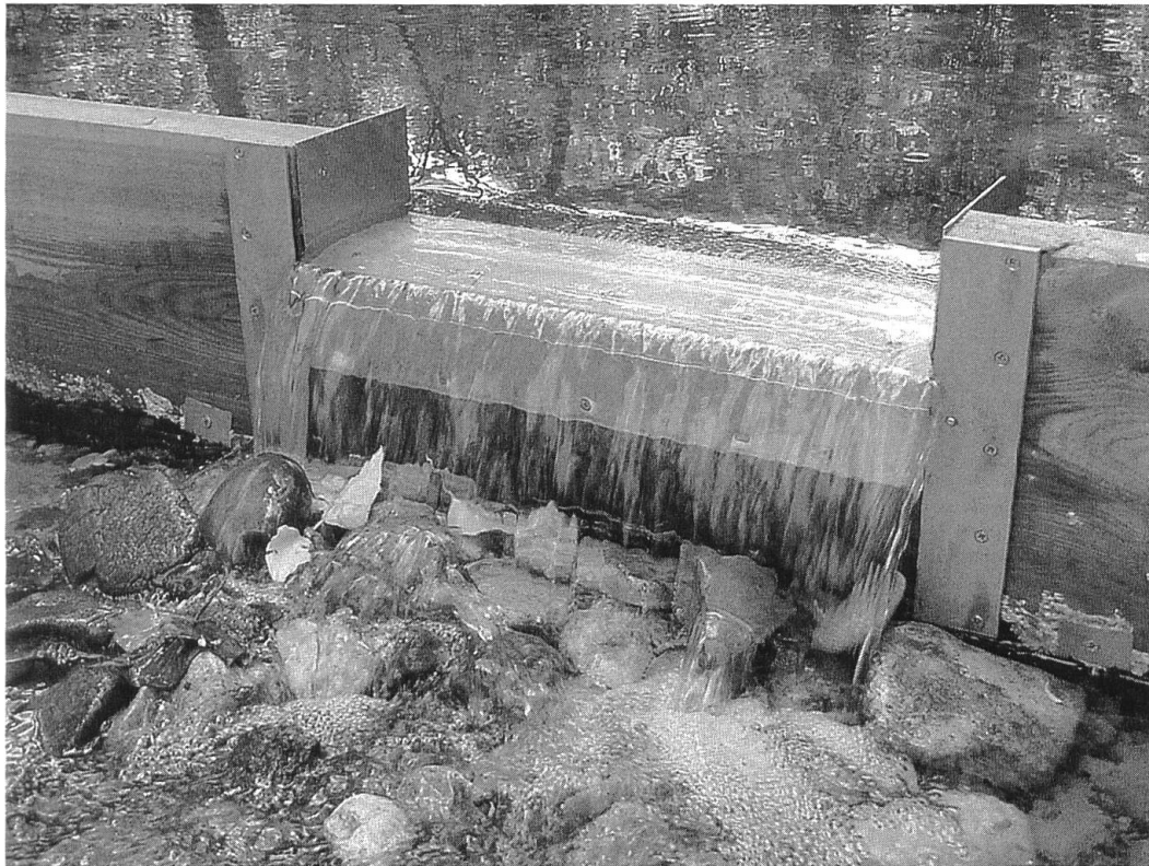
Abb. 3 Über dieses Einleitungsbauwerk fliesst das Birswasser aus dem Teichbächlein in das Pflanzenklärgelände hinein. Ein Absetzbecken für die Sedimente ist nicht vorhanden. (Aufnahme Mai 2003) Photo: O. Stucki
