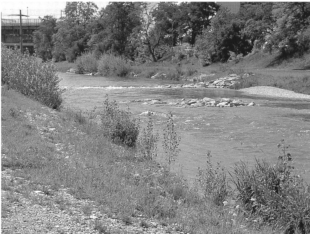
Abb. 1b Das Birsufer nach der Revitalisierung. (Aufnahme 04.08.2004)
