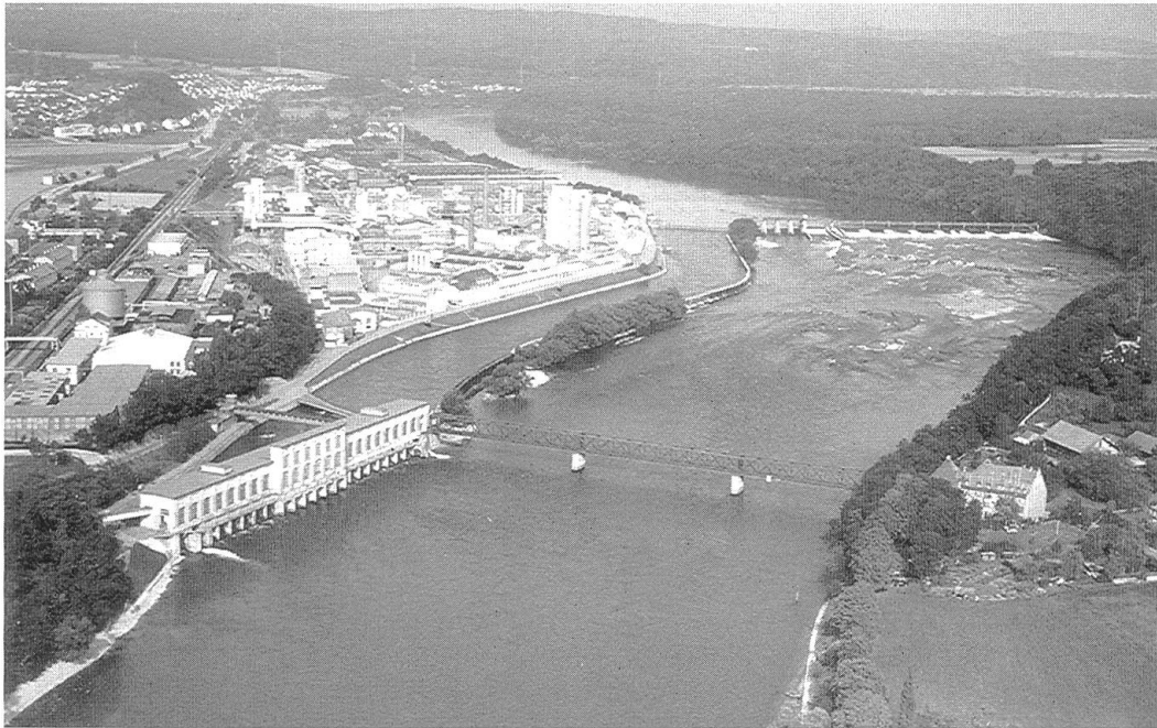
Abb. 1 Kraftwerk Rheinfelden mit Oberwasserkanal und altem Wehr in den Stromschnellen "G'wild" (Zustand vor 2003). Quelle: KWR AG
