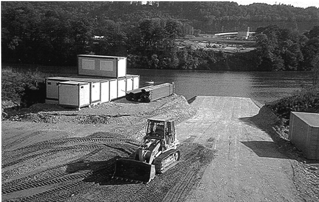
Abb. 7 Der für 2005 vorgesehene Brückenschlag über den Rhein als Teil der Querspanne zwischen deutscher und schweizerischer Autobahn. Photo: B. Mohr 10/2003
