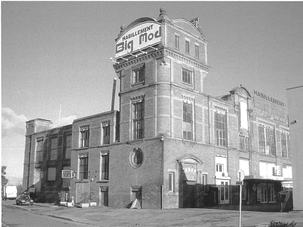
Abb. 5 Umgenutzte Textilfabrik in Colmar.
