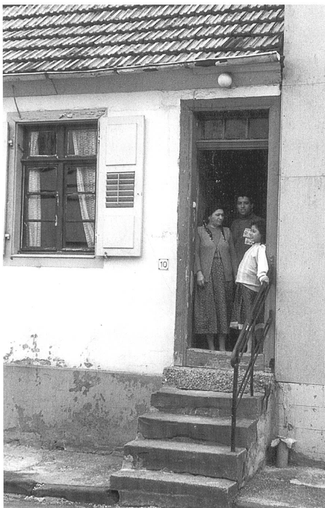
Fig. 4 Les difficultés de logement des ménages en situation de précarité. Parc locatif dégradé à Bischwiller.
