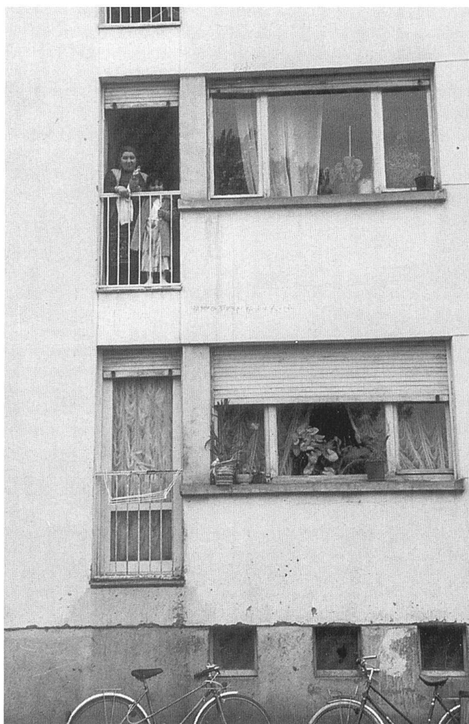
Fig. 3 Les difficultés de logement des ménages en situation de précarité. Parc locatif dégradé à Bischwiller.
