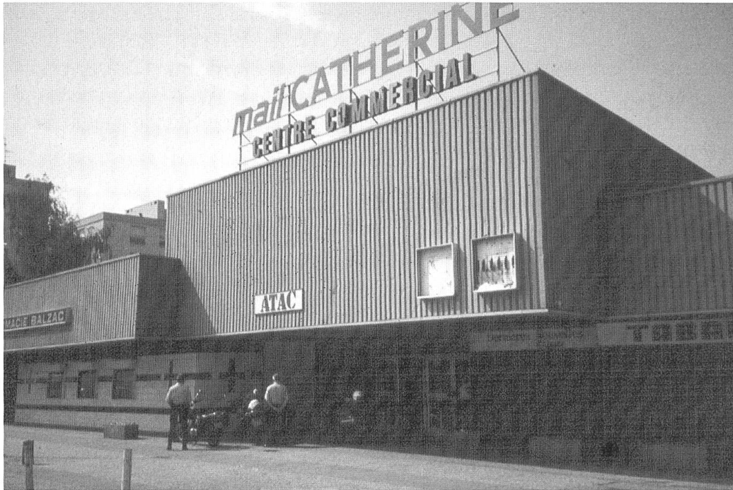
Fig. 1 Un quartier résidentiel à hauts risques : le Centre Commercial quasi à l'abandon gardé par la police – la pharmacie est transformée en « Bunker ». Photo : G. Wackermann
