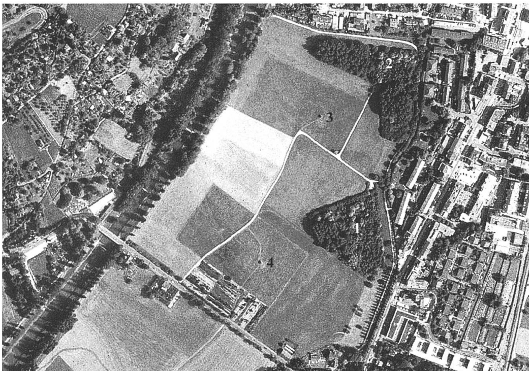
Abb. 2 Luftbild im Bereich der beiden Wasserstellen “Vordere und Hintere Stellmatte” (1 und 2). Die als Pflanzenfilter umfunktionierte “Hintere Stellmatte” ist auf dem Bild oben rechts zu sehen, direkt daneben der Mühlenteich. Die aus dem Schwarzwald kommende Wiese fließt unten links in Richtung Basler Rheinufer. Als dunkle Punkte in den Landwirtschaftsflächen der “Langen Erlen” zu sehen: die Trinkwasserbrunnen 9 und 8 (3 und 4).
