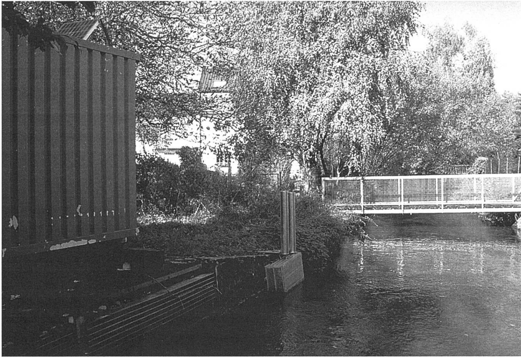
Abb. 3 Mühlenteich mit den beiden Sensoren des “Eingangswächters” (Bildmitte) und dem Container, in dem sich die Steuerelektronik und die Datenfernübertragung befindet.
