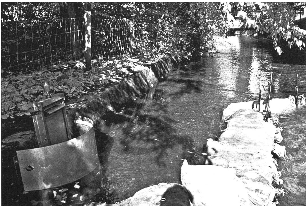
Abb. 4 Ausleitung vom Mühlenteich in die Wasserstelle “Stellmatte”. Gut sichtbar das Öl-Abweisblech, das auf das Fischgitter aufgeschraubt wurde. Bei Durchlauf einer Trübungswelle oder bei erhöhten SAK 254-Werten wird dieser Schieber automatisch geschlossen.
