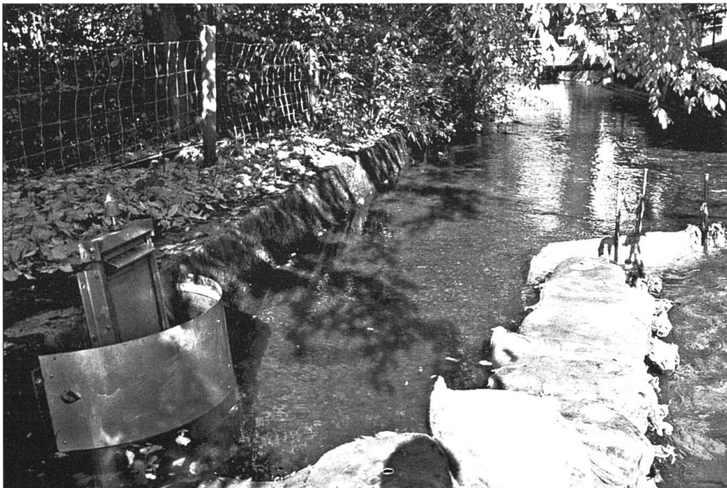
Abb. 4 Ausleitung vom Mühlenteich in die Wasserstelle “Stellimatte”. Gut sichtbar das Öl-Abweisblech, das auf das Fischgitter aufgeschraubt wurde. Bei Durchlauf einer Trübungswelle oder bei erhöhten SAK 254-Werten wird dieser Schieber automatisch geschlossen.
