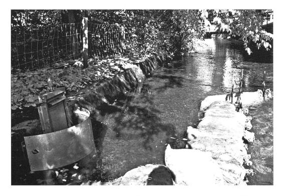
Abb. 4 Ausleitung vom Mühlenteich in die Wässerstelle "Stellimatte". Gut sichtbar das Öl-Abweisblech, das auf das Fischgitter aufgeschraubt wurde. Bei Durchlauf einer Trübungswelle oder bei erhöhten SAK 254-Werten wird dieser Schieber automatisch geschlossen.
