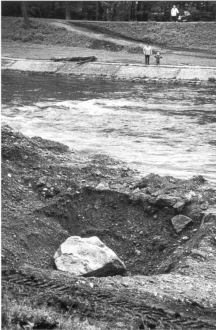
Abb. 3 Das 2 m tiefe Baggerloch beim Bau von Buhnen bei der Revitalisierungsstrecke zeigt, dass infolge Kolmatierung der Flusssohle kein Wasser von der Wiese ins Baggerloch gelangt.
