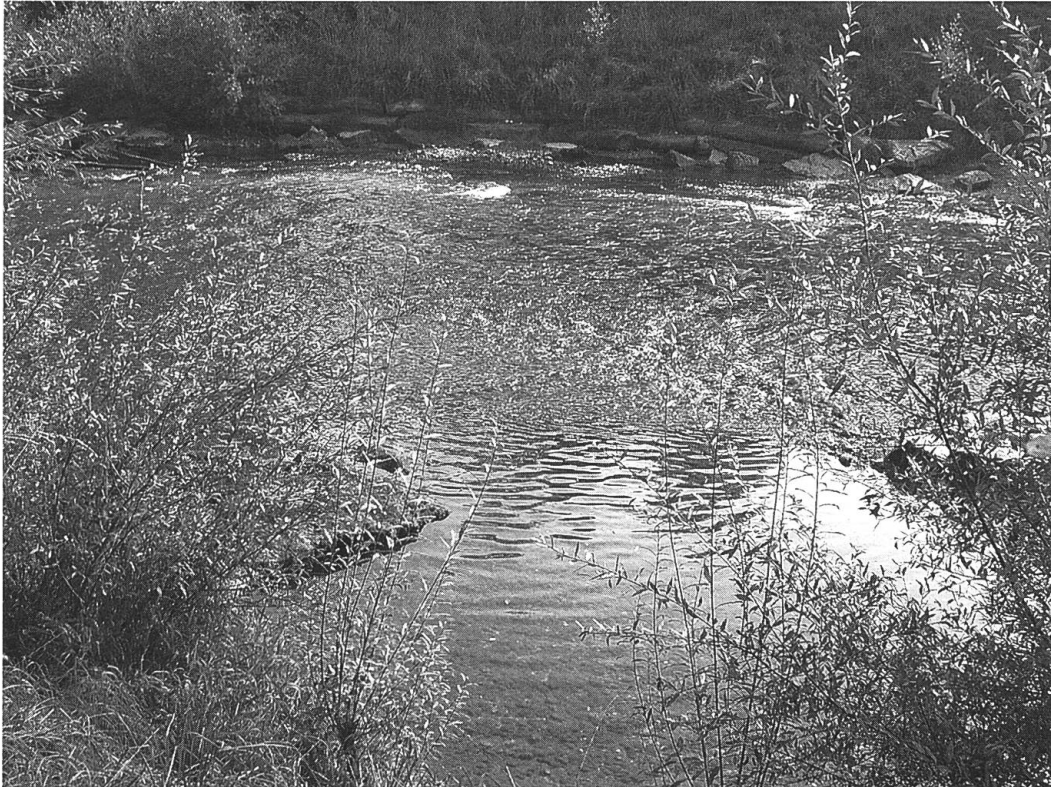
Abb. 2 Wichtiges Merkmal der Birsrevitalisierung im Münchenstein ist eine erhöhte Variabilität der Strömungsbedingungen und die Entstehung von “riffles” und “pools”.
