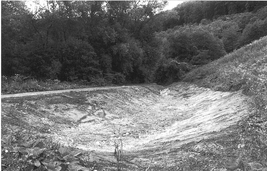
Abb. 4 Flutmulde (nach Bau).
