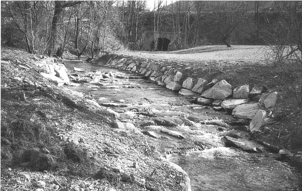
Abb. 10 Ein 1.2 Meter hoher Absturz am Homburgerbach, einem Seitengewässer der Ergolz, wurde durch die erfahrene Unterhaltsequipe des Tiefbauamtes Kanton Basel-Landschaft, Hauptabteilung Wasserbau, in eine nun für Wasserlebewesen durchgängige Blockrampe umgebaut (April 2000). Photo: A. Schenker
