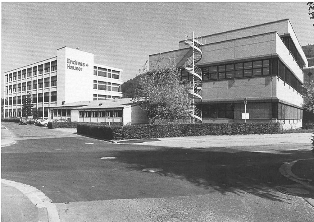
Abb. 4 Grösste Betriebsstätte der internationalen Endress+Hauser-Firmengruppe mit mehr als 1'100 Mitarbeitern. In Maulburg werden Füllstand- und Druckmessgeräte entwickelt und produziert.
