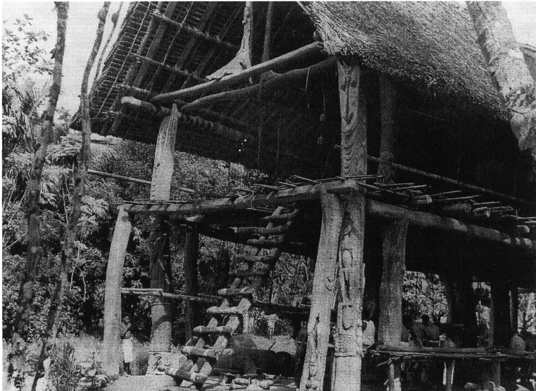
Abb. 2 Schwerpunktregion Melanesien: Giebelfront eines Männerhauses im Dorf Kanganaman der Iatmul (Mittelsepik, Papua New Guinea) mit geschnitzten Pfosten, Giebelfigur, liegenden Schlitztrommeln, hohen Sitzplattformen an den Längsseiten und Treppe zum hier offenen Obergeschoss. Das Männerhaus ist zugleich das Kultgebäude; die Schnitzwerke stellen Gestalten aus der reich entfalteten Mythologie dar. (Foto: G. Schuster)
