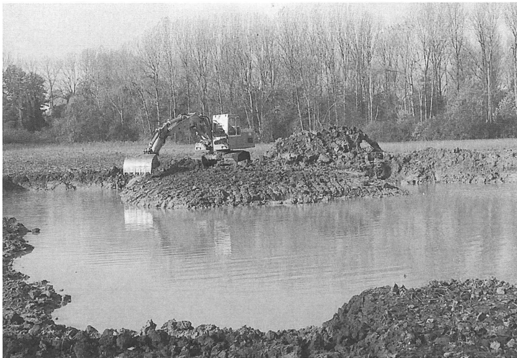
Abb. 1 Die fehlende Dynamik der Au muss durch Maschinen ersetzt werden, mit denen ehemalige Altarme (die sogar bewirtschaftet wurden) wieder als offene Wasserflächen freigelegt werden. Im Bild 3.1. (vgl. Abb. 3).
