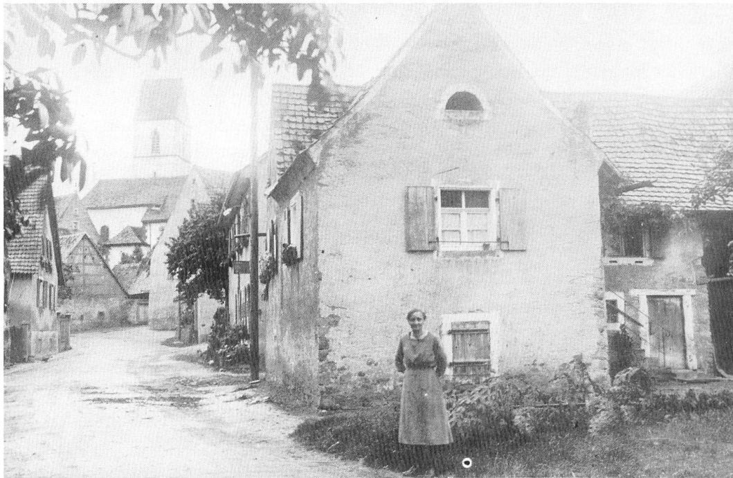
Abb. 2 Der südliche Dorfeingang auf einer Aufnahme von ca. 1922. Im Bild Maria Heitzler. (Bild wiedergegeben mit freundlicher Genehmigung des Gemeindecarchivs Pfaffenweiler.)
