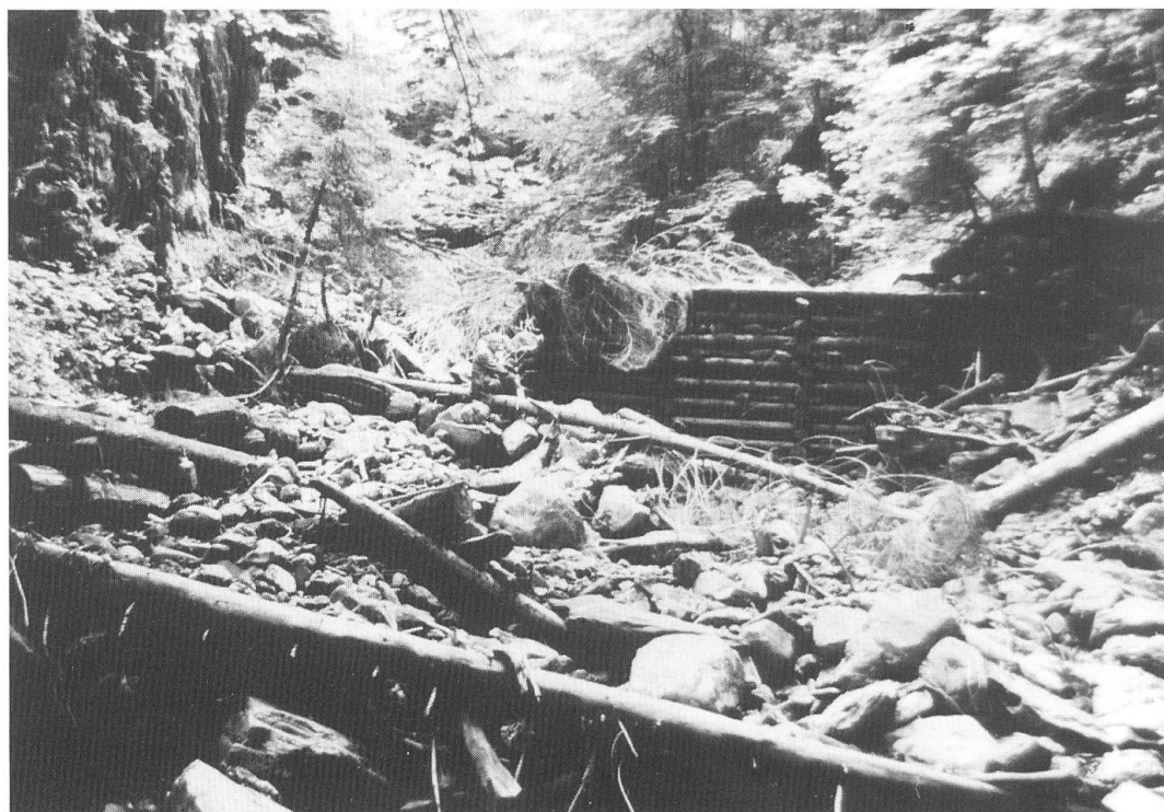
Abb. 1 Mangelnder Gewässerunterhalt; zerstörte Verbauungen erhöhen das Gefahrenpotential. Aufnahme: H.P. Willi, Bundesamt für Wasserwirtschaft, Bern
