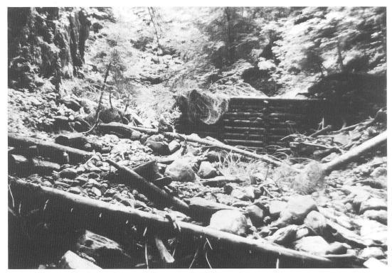
Abb. 1 Mangelnder Gewässerunterhalt; zerstörte Verbauungen erhöhen das Gefahrenpotential.
