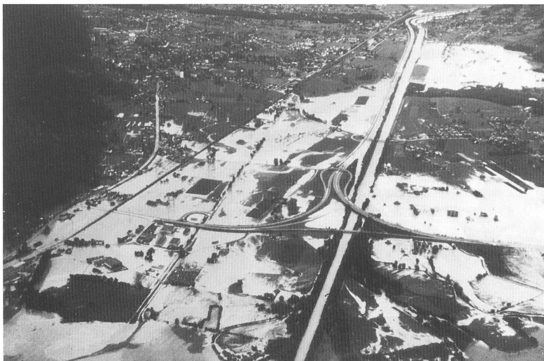
Abb. 2 Dammbüche mit Überschwemmungen bei Hochwasser 1987, Reussebene im Kanton Uri. Aufnahme: H.P. Willi, Bundesamt für Wasserwirtschaft, Bern
