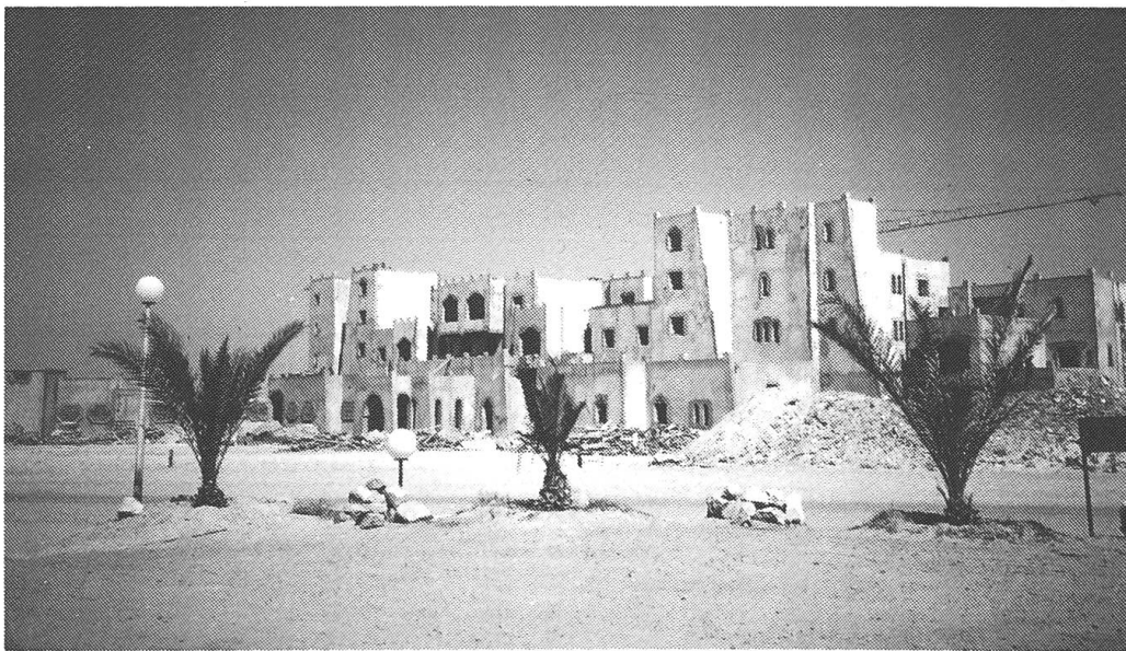
In der Hotelzone südlich von Douz: Baustelle für Touristenghetto trotz Widerstandes der Bauern. (1990)
