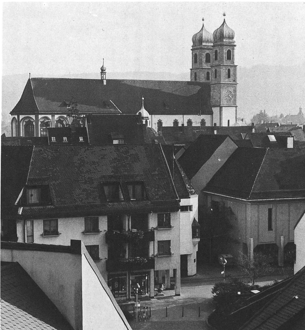
Abb. 1 Dachlandschaft im Bereich des Rheintal zentrums
