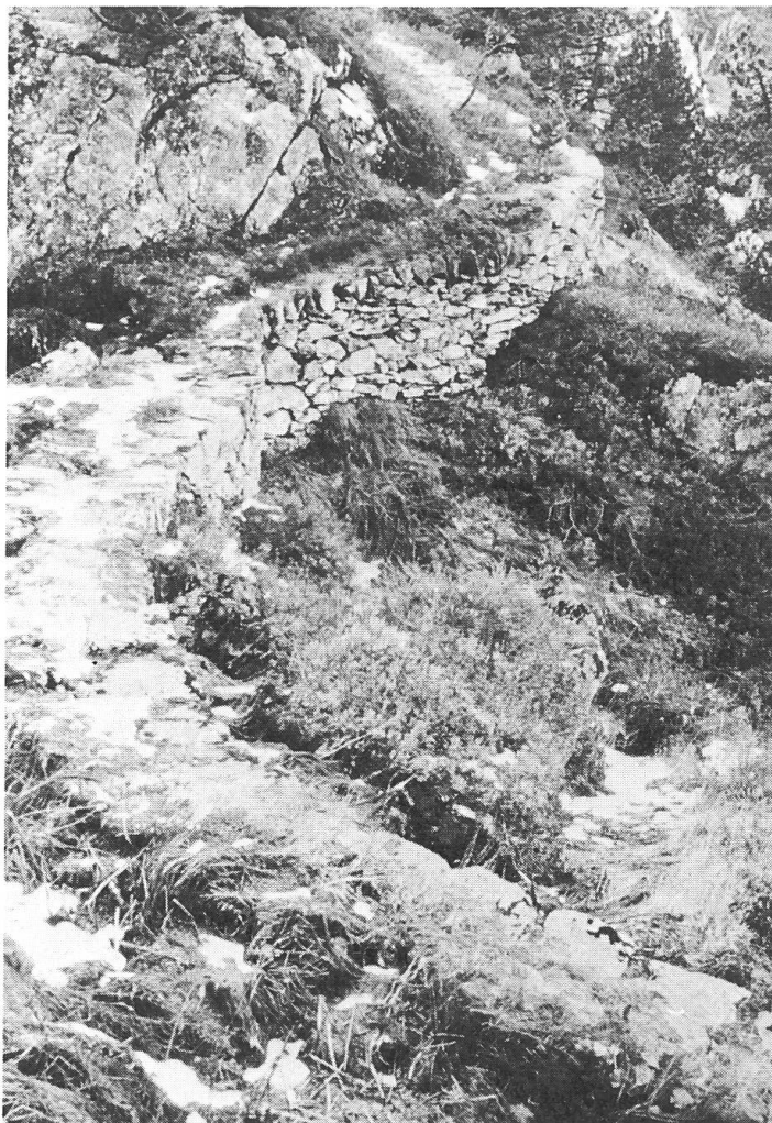
Abb. 1: Der spätmittelalterliche Sustenpassweg auf der Südseite des Wyssenmadhubels (LK 1211, 4 km östlich von Gadmen, 674 000 / 175 900 / 1770 m). Der Wegkörper ist 1 m breit und etwa 2 m hoch, als Trockenmauer errichtet und auf über 100 m Länge intakt. Er lässt sich problemlos in einen Wanderweg integrieren, der dem Wanderer die Benutzung der Autostrasse ersparen würde (Germann 1982, 77 - 83).
