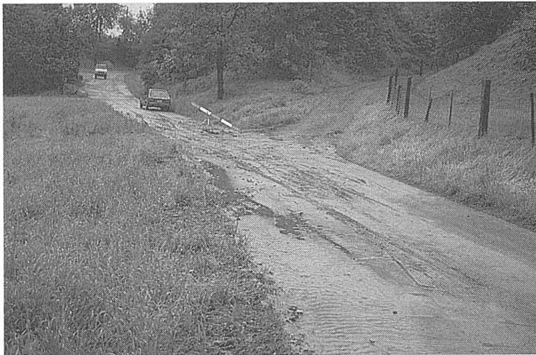
Abb. 5 Die Strasse entlang der Terrassenkante wurde im Mai 1986 unterhalb der Flur Tiefegrund wegen Verschüttung durch ein starkes Bodenerosionsereignis gesperrt. Auf einer Länge von 100 m musste der Strassenbelag erneuert werden.
