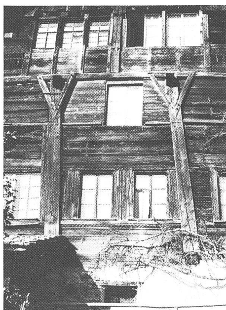
Abb. 3 Ausschnitt einer Giebelwand eines alten Ständerbaus. Durchgehende Ständer mit Kopfhölzern. Langriegel mit Würfelfries. Oberteil des Hauses nachträglich verändert. Eschenbach, Ermenswil, Kt. St. Gallen. Datiert 1646. Quelle: Zentralarchiv für Bauernhausforschung, Foto: M. Gschwend .
