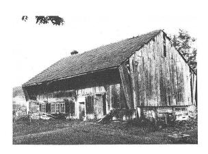
Abb. 2 Vielzweckbau in Ständerbauweise mit Ankerbalken beidseits des Tenntors. Stallteil nachträglich in Mauerwerk. Montet, Kt. Freiburg. Quelle: Zentralarchiv für Bauernhausforschung, Foto: M. Gschwend.
