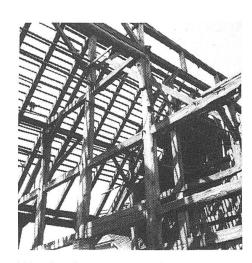
Abb. 4 Gerüst eines Mehrständerbaus, deutlich sichtbar die Holznagelung. Aufnahme anlässlich des Hausabbruches. Dompierre, Kt. Waadt. Quelle: Zentralarchiv für Bauernhausforschung, Foto: M. Gschwend.
