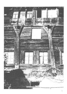
Abb. 3 Ausschnitt einer Giebelwand eines alten Ständerbaus. Durchgehende Ständer mit Kopfhölzern. Langriegel mit Würfelfries. Oberteil des Hauses nachträglich verändert. Eschenbach, Ermenswil, Kt. St. Gallen. Datiert 1646. Quelle: Zentralarchiv für Bauernhausforschung, Foto: M. Gschwend.
