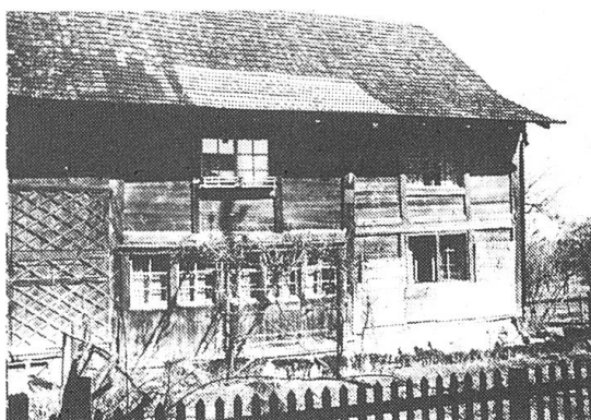
Abb. 1 Kleiner Ständerbau aus dem 17. Jahrhundert, mit durchgehenden Ständern und Kopfhölzern, Gefachfüllung aus Bohlen. Diessenhofen, Kt. Thurgau. Photo: Kantonale Denkmalpflege Thurgau.
