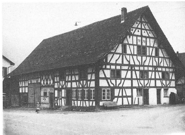
Abb. 7 Vielzweckbau in Fachwerkkonstruktion. Stadel, Kt. Zürich. Datiert 1668. Quelle: Zentralarchiv für Bauernhausforschung, Foto: M. Gschwend.
