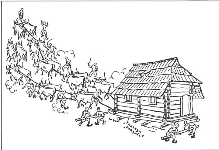
Abb. 8 Verschiebung eines Holzhauses in Bosnien, nach A. Deroko, Narodno neimarstvo, Beograd 1968. Publiziert in D. St. Pavlowitch, Anm. 10.
