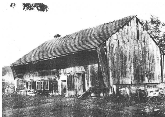
Abb. 2 Vielzweckbau in Ständerbauweise mit Ankerbalken beidseits des Tenntors. Stallteil nachträglich in Mauerwerk. Montet, Kt. Freiburg. Quelle: Zentralarchiv für Bauernhausforschung, Foto: M. Gschwend .
