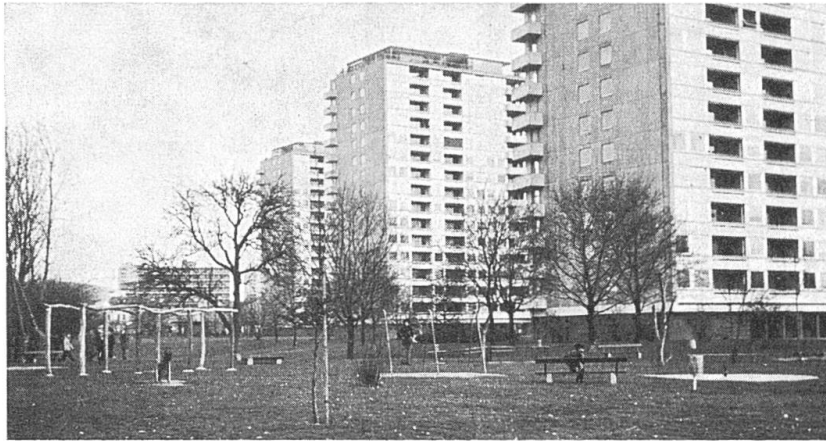
Abb. 1 Birsfelden, Rheinpark- Hochhäuser, Blick gegen Osten (Aufnahme H. Polivka 1978)
