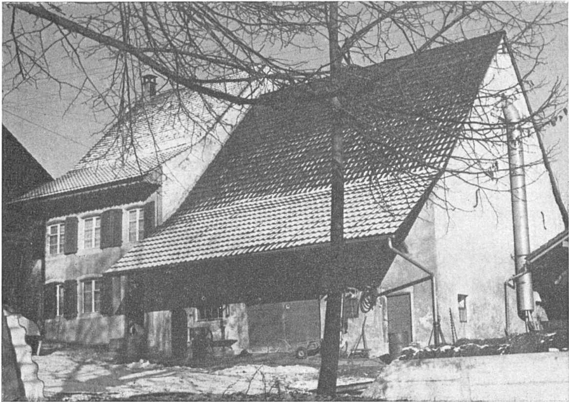
Abb. 3 Vielzweckbau mit bäuerlicher Dominante (Ökonomieteil ist grösser als Wohnhaus) in Arboldswil, Winkel 4. Wohnhaus verspäteter Barock, Scheune 1697, zwei Ställe. 1981 einer der vier Dorfbauernbetriebe
