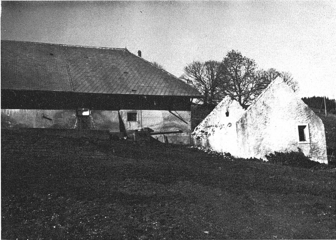
Abb. 3 Untere Tannmatt, 1057 m, Blick nordostwärts. Das Gebäude dient heute nur noch als Sömmerungsstall für Jungtiere. Das Dach des zerfallenden ehemaligen Milchkellers ist 1978 entfernt worden.
