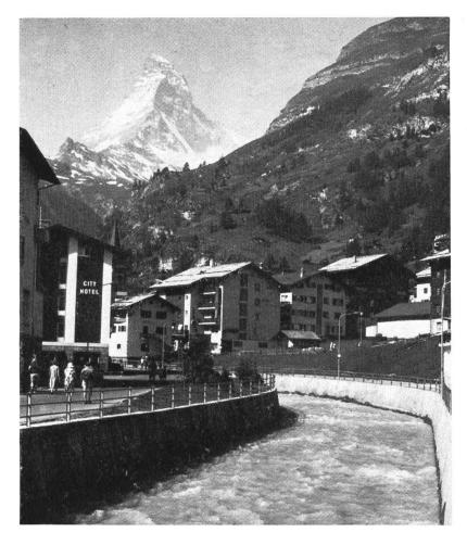
Abb. 8 Die Mattervispa in Zermatt. Das verschalte Gerinne ist für die schadlose Abführung der durch die alljährlichen Ausbrüche des Gornersees verursachten Abflusspitzen (um 50 m³/sec) dimensioniert. Aufnahme: W. H. 3. 8. 80
