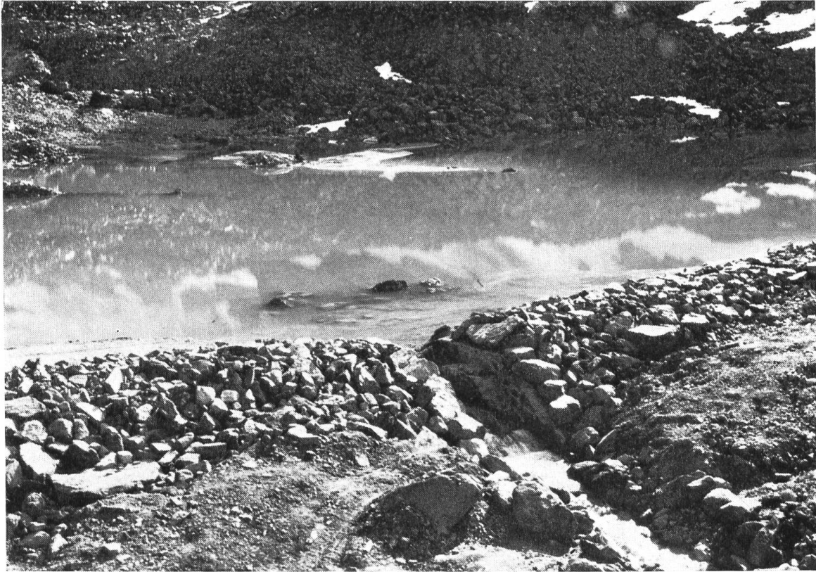
Abb. 10 Blockwurf und betonierter Überlauf am See 1 beim Grubengletscher. Durch die bauliche Massnahme wurde die Überlaufschwelle des proglazialen Sees vor rückschreitender Erosion geschützt und zugleich ein Retentionsbecken für kleinere Wasserausbrüche im Gebiet des Grubengletschers geschaffen. Helikopteraufnahme W. Schmid, 26. 8. 80
