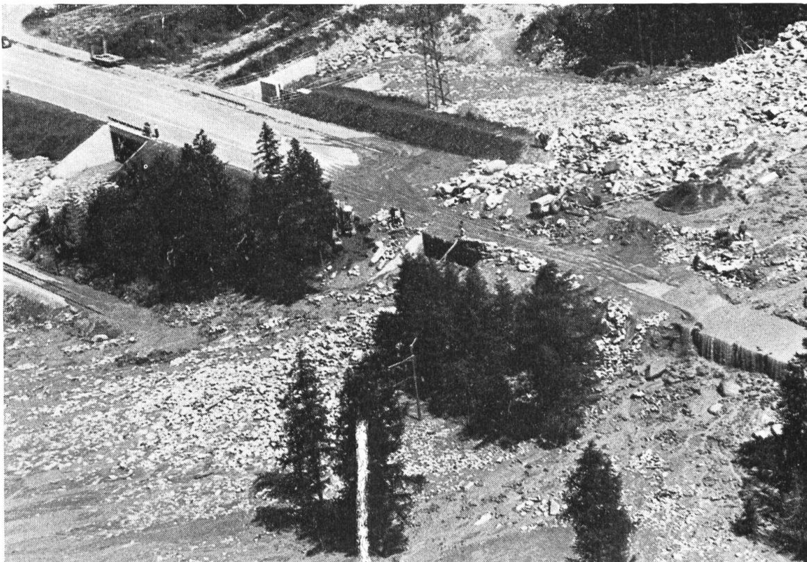
Abb. 7 Verschüttete Strasse und Bahnlinie im Mattertal nach einem Wassertaschenausbruch am Kingletscher/Wildibach 1978. Aufnahme Keystone Press
