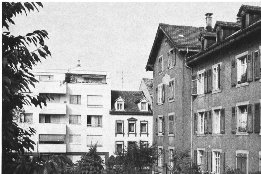
Abb. 6: Rechts im Bild ein 3 1 / 2 geschossiges Arbeiterwohnhaus in schlechtem Zustand, in der Bildmitte ein restauriertes 2 1 / 2 geschossiges Haus, links ein neuer Wohnkomplex mit maximaler Bauhöhe. – Beachtenswert die Kontraste: Höhe, Fensterfläche, Fensterumrandung (Fensterläden), Fassadengestaltung, Dachform usw.
