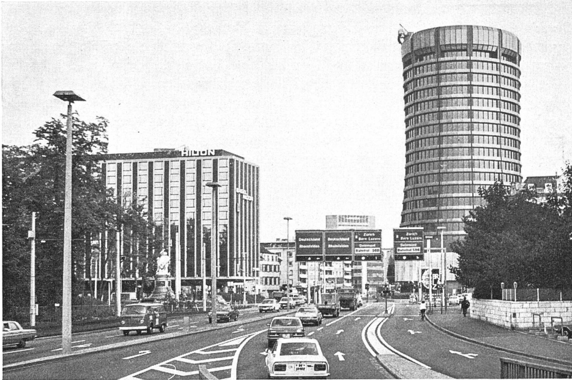
Abb. 3 Die Basler Bahnhof-City mit dem BIZ-Turm (Bank für Internationalen Zahlungsausgleich) und einem unterirdischen Ladenzentrum zwischen Bahnhof und Strassburger Denkmal,
