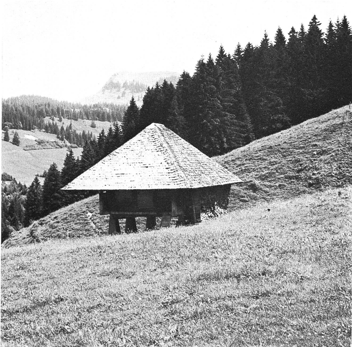
Abb. 13 Alp Rämsiboden, Kässpeicher auf Stützel, Walmdach mit Schindelndeckung.
