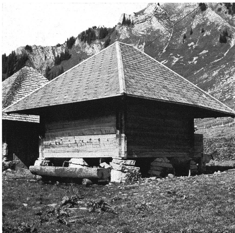
Abb. 44 Speicher auf Alp Mittlist Arni. Blockbau mit Walm- dach, Eternitdeckung, vor dem Speicher ein Tränkebrunnen.
