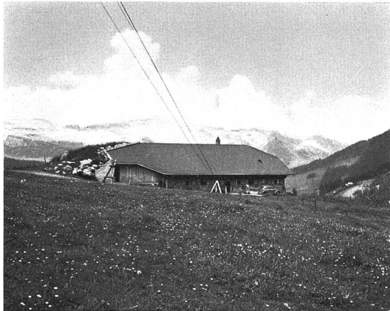
Abb. 12 Alp Rämsiboden, Ansicht des neuen Alpgebäudes, links der grosse Lawinen- keil.
