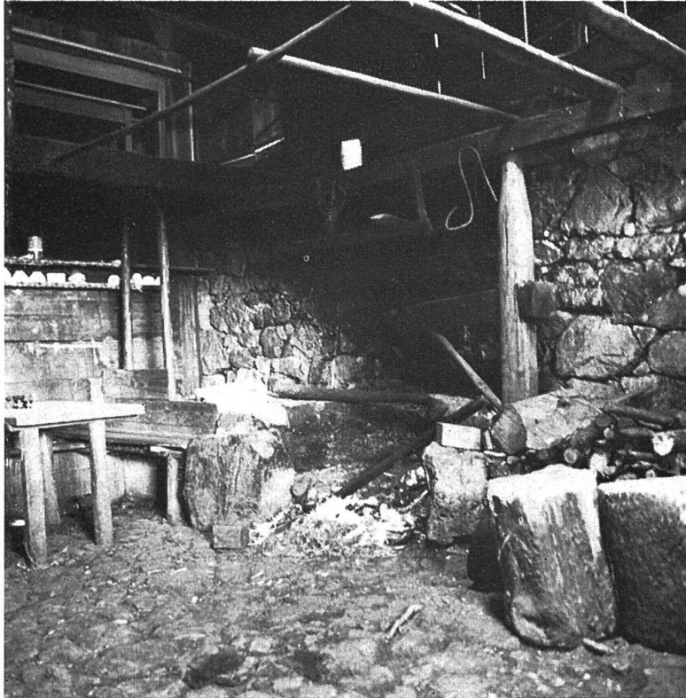
Abb. 35 Alte Feuerstelle in einer Sennhütte, ummauerter Feuerplatz («Firgruobe»), rechts hölzerner, drehbarer Galgen («Turner») an dem das Käskessi übers Feuer gedreht wird, links Tisch, Sitzgelegenheit und Tellerbrett. Alp Alpoglen.
