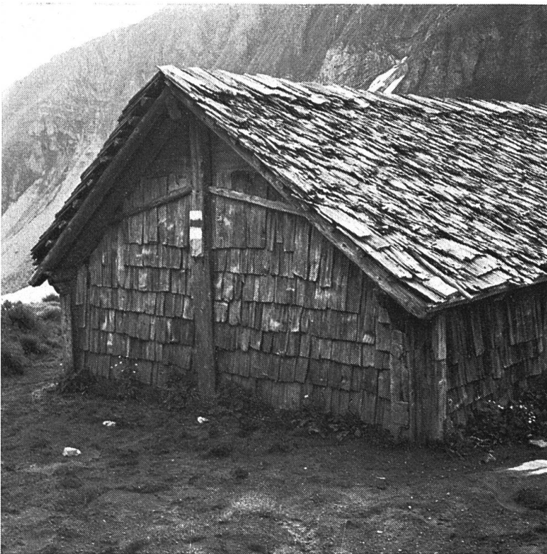
Abb. 31 Ständerkonstruktion mit Flecklingen. Aussenseiten teilweise verschindelt. Alp Eisee.
