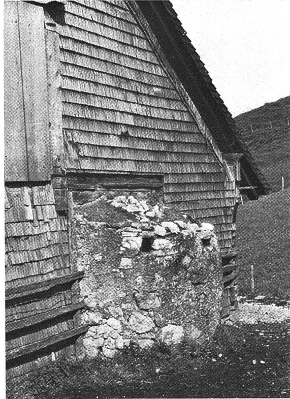
Abb. 36 Aussenwand mit vorgemauerter Herdstelle und Rauchlöchern. Zurgilgenhütte/Jänzimatt.
