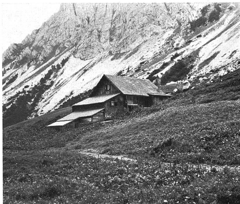
Abb. 48 Orthütte auf der Alp Fontanen. Einzelstehende Sennhütte mit giebelseitigen Anbauten unter Pultdächern (vgl. Situationsplan Abb. 9).
