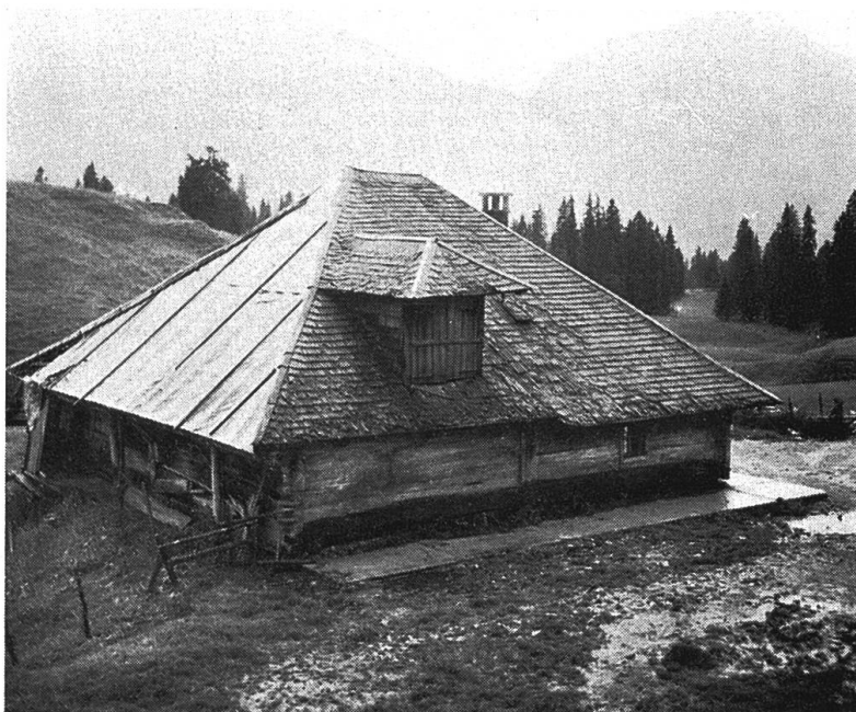
Abb. 33 Grosse Alphütte mit Sennereiraum (Kamin nachträglich eingebaut) und Stall. Walmdach teilweise mit Schindeln gedeckt, teilweise mit Blech. Dachausbau als Zugang zum Heuraum. Alte Lochhütte, Alp Glaubenbüelen.
