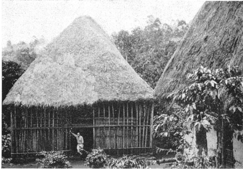
Abb. 1 Das Männerhaus im Gehöft von P. F. Tita Musing. Auffallend sind die vielen Pfosten, welche das mächtige Grasdach stützen.
