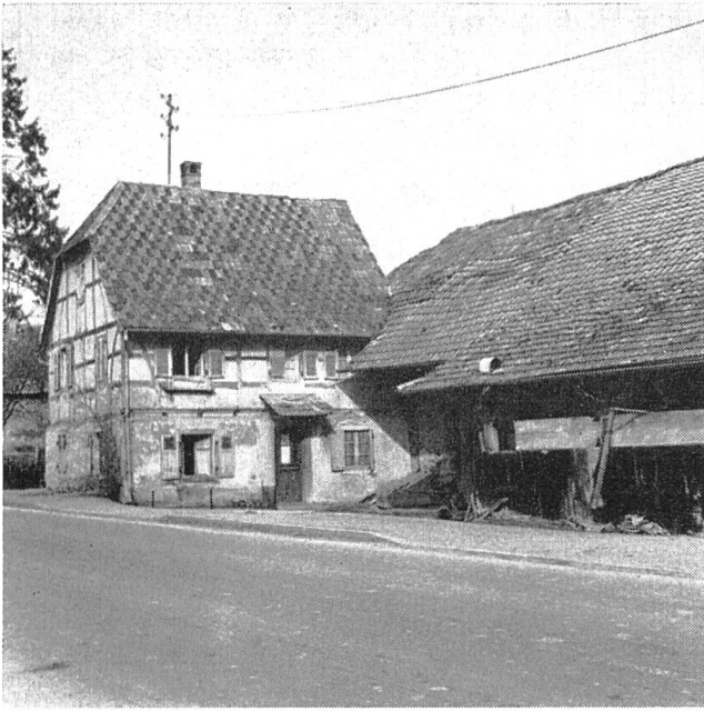
Abb. 35 Wenn Wohn- und Wirtschaftsbau in der ursprünglichen Stellung zusammengestossen werden, entstehen Winkelhöfe. Attenschwiller F.
