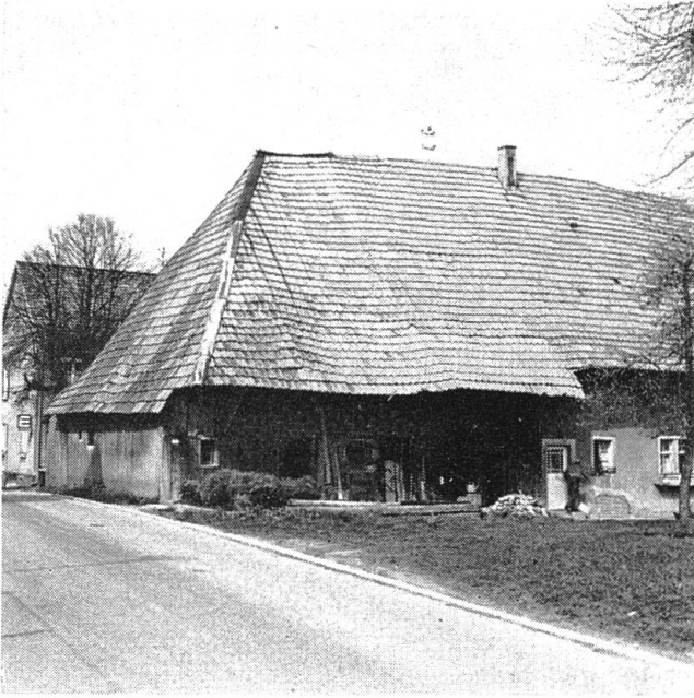
Abb. 22 Eines der wenigen erhaltenen alten Walmdachhäuser (über dem Wohnteil ist der Walm bereits ersetzt), das im Inneren noch eine Hochstud besitzt. Adelshausen D (1726).
