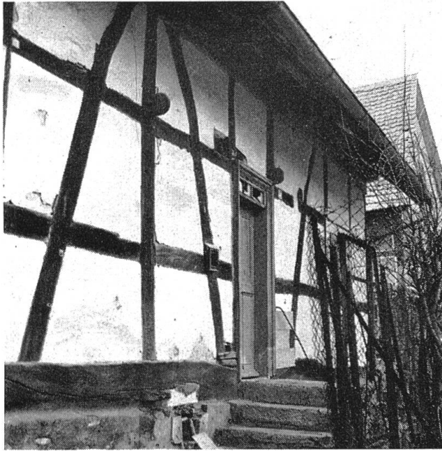
Abb. 13 Vielzweckbau mit zwei durch den Wohnteil durchgehenden Ankerbalken, deren Köpfe oberhalb des Türriegels durch die Zwischenständer durchgesteckt sind. Ranspach-le-Bas F.
