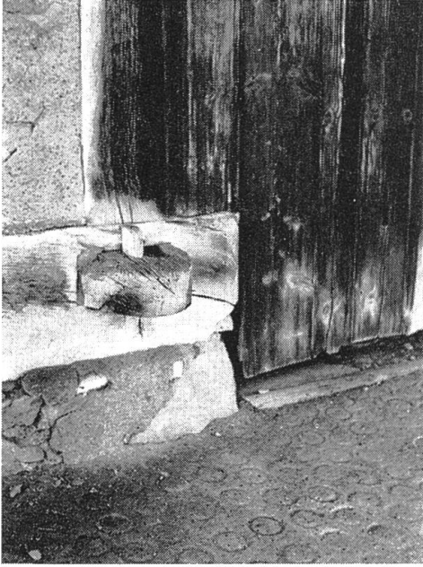
Abb. 11 Durchgezapfte und mit Holznagel gesicherte Schwelle einer Scheune. Wentzwiller F.
