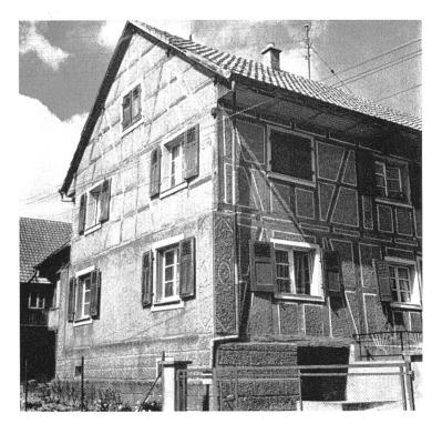
Abb. 10 Fachwerkhaus mit giebelseitig vorgesetzter Vermantelung des Fachwerkes im Erdgeschoss. Attenschwiller F.
