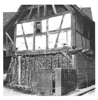
Abb. 19 Ein Nebengebäude einer alten Hofanlage (erbaut 1621) zeigt das alte Prinzip des überkämmten Ankerbalkens. Holzen D.
