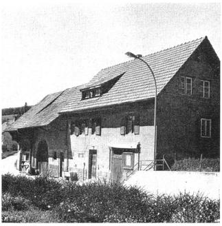
Abb. 52 Gestelzter Bau, im Untergeschoss Stall und Keller, angehängte dreiteilige Scheune (Stall/Tenn/Stall). Inzlingen D.
