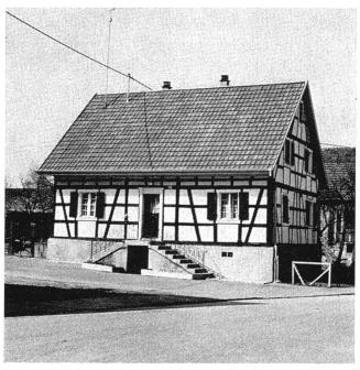
Abb. 42 Unterkellertes Kleinhaus mit Kniestock. An der Traufseite eine repräsentative, doppelläufige Steintreppe. Knoeringen F.
