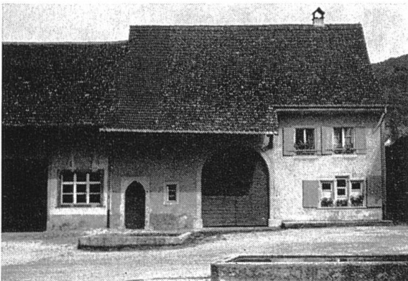
Abb. 37 Sekundärer Vielzweckbau ohne äussere Trennung von Wohn- und Wirtschaftsteil, sog. Mittertennhaus. Muttenz BL.
