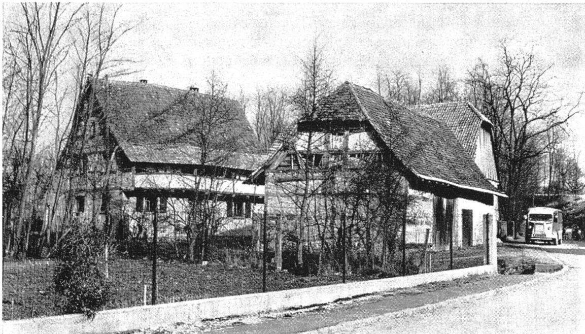
Abb. 33 Hof, bestehend aus freistehendem Wohnhaus (links) und zugehörigen Wirtschaftsgebäuden. Steinbrunn-le-Haut F.
