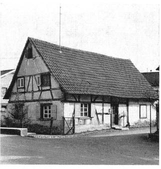
Abb. 40 Kleinhaus mit nachträglicher Erweiterung rechts (vgl. Grundriss, Abb. 43). Das Haus besitzt keinen Keller, die Schwellen liegen auf einem niedrigen Mauersockel. Steinbrunn-le-Haut F. Vgl. Querschnitt Abb. 15.
