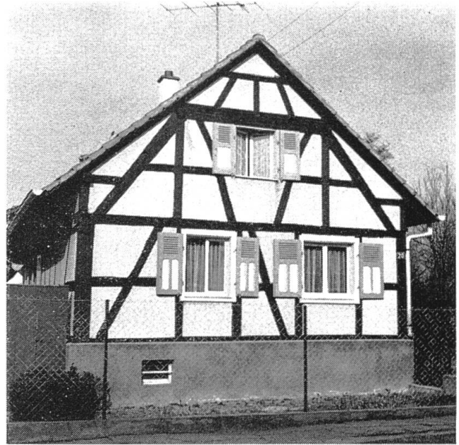
Abb. 28 Der Kniestock ermöglicht nachträglich eine flachere Dachneigung. Steinbrunn-le-Haut F.
