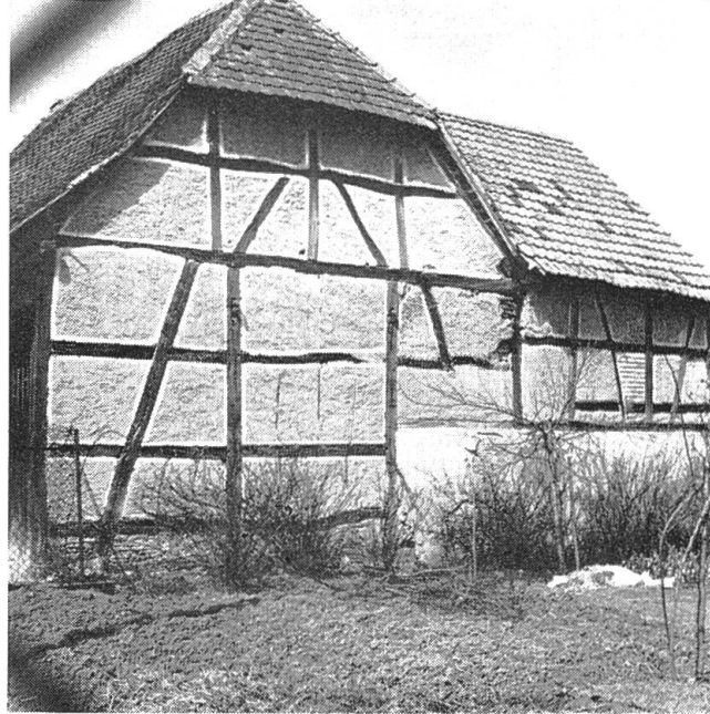
Abb. 12 Scheune mit altem Fachwerk an der Giebelwand, durchgehenden Ständern, Langstreben von der Schwelle zum Rähm (rechts nachträglich zerstört), grossen, nur wenig unterteilten Gefachen und Langriegeln. An den beiden Zwischenständern sind die durchgesteckten Zangenköpfe sichtbar. Willer F.
