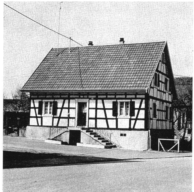
Abb. 42 Unterkellertes Kleinhaus mit Kniestock. An der Traufseite eine repräsentative, doppelläufige Steintreppe. Knoeringen F.
