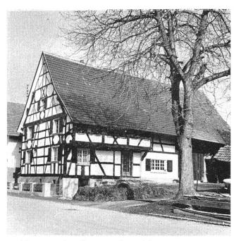
Abb. 47 Sekundärer Vielzweckbau, renoviert. Von der dreiteiligen Scheune wurde der eine Stallteil zu Wohnzwecken ausgebaut. Linsdorf F.
