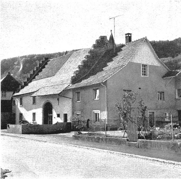
Abb. 27 Sparrendächer weisen häufig einen Knick auf, der erlaubt, die Dachfläche stärker über die Traufwand hinauszuziehen. Hier noch ein Haus mit Treppengiebel. Hertzen D.
