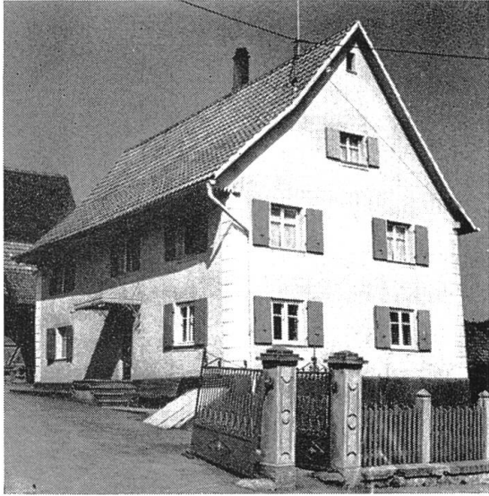
Abb. 44 Mittelflurhaus mit zwei Wohngeschossen, den Übergang vom Kleinhaus demonstrierend. Vollständig verputztes Fachwerk. Knoeringen F.
