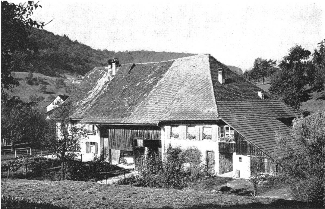
Abb. 7 Im Innern dieses aus verschiedenen Bauteilen zusammengesetzten Bauernhauses ist noch teilweise ein Hochstud-Ständergerüst erhalten. Rothenfluh BL.
