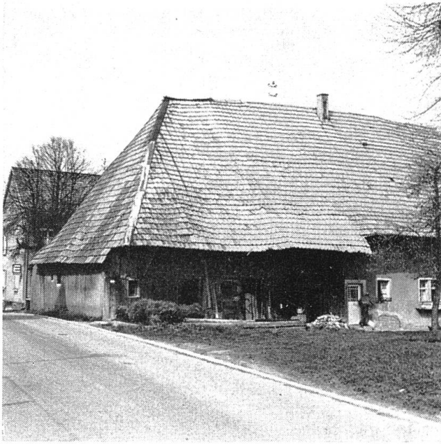
Abb. 22 Eines der wenigen erhaltenen alten Waldachhäuser (über dem Wohnteil ist der Walm bereits ersetzt), das im Inneren noch eine Hochstube besitzt. Adelshausen D (1726).
