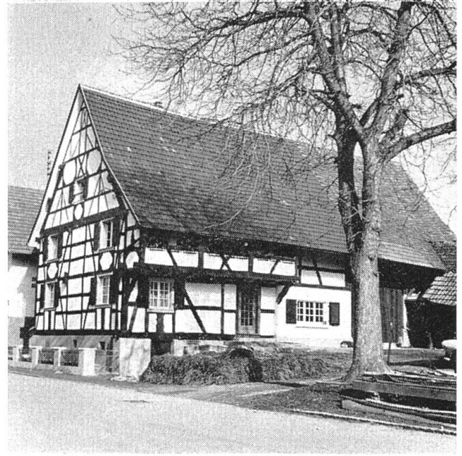
Abb. 47 Sekundärer Vielzweckbau, renoviert. Von der dreiteiligen Scheune wurde der eine Stallteil zu Wohnzwecken ausgebaut. Linsdorf F.
