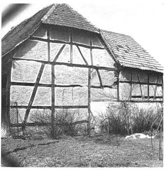
Abb. 12 Scheune mit altem Fachwerk an der Giebelwand, durchgehenden Ständern, Langstreben von der Schwelle zum Rähm (rechts nachträglich zerstört), grossen, nur wenig unterteilten Gefachen und Langriegeln. An den beiden Zwischenständern sind die durchgesteckten Zangenköpfe sichtbar. Willer F.
