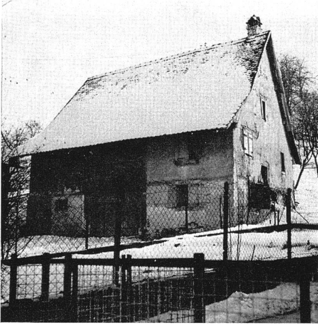
Abb. 39 Ehemalige dreiteilige Scheune einer Hofanlage mit nachträglich eingebautem Wohnteil (sekundärer Vielzweckbau). Winkel F.
