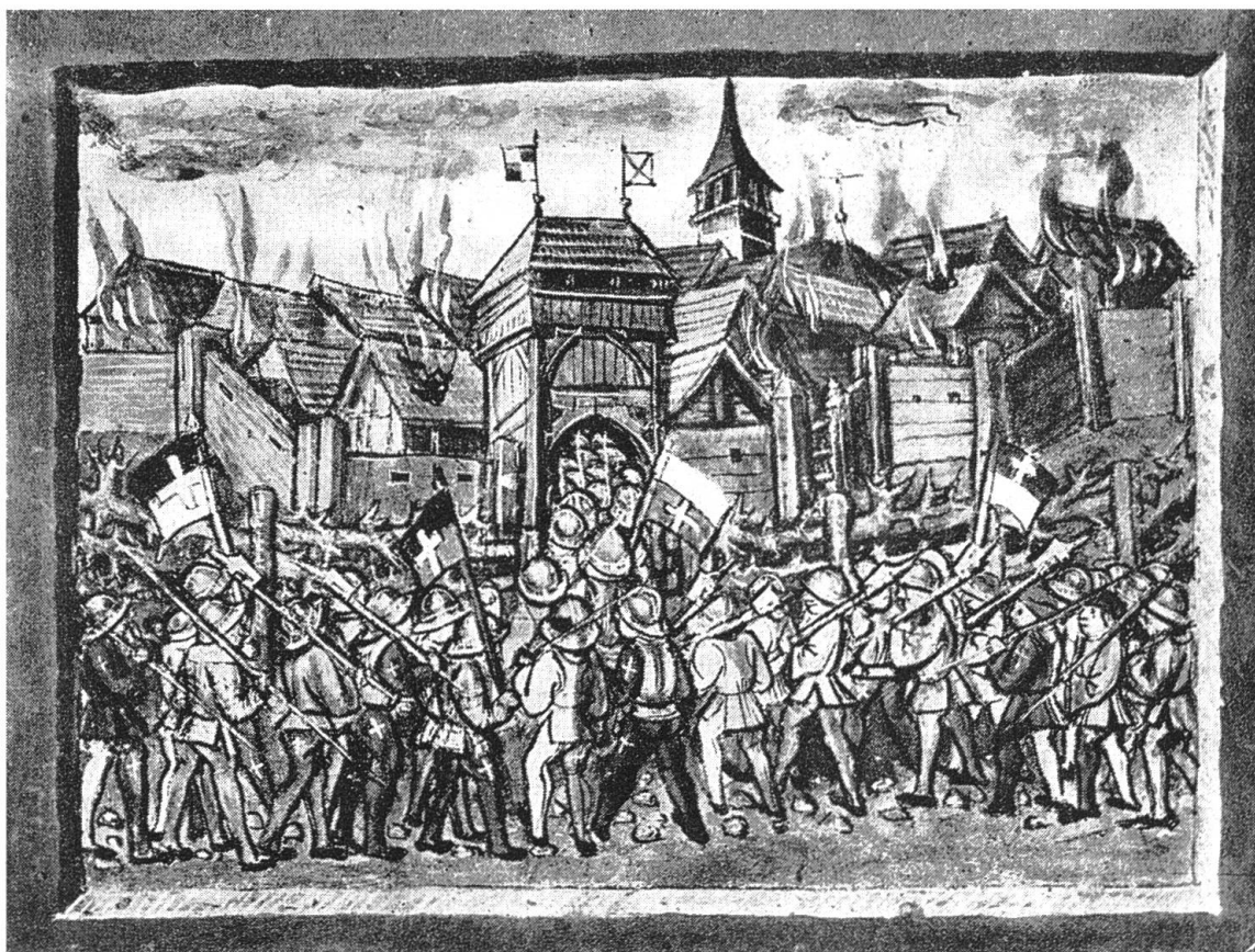
Abb. 5 Die hölzerne Stadt-«Mauer» von Habsheim im Elsass, eine Ständerwand mit liegenden Bohlen; D. Schilling , 1513 (Reproduktion Universitätsbibliothek Basel).
