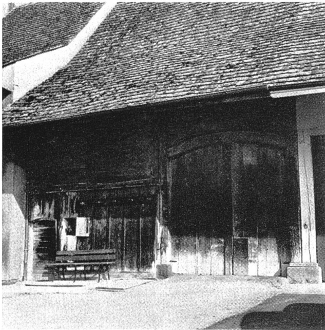
Abb. 6 Ständerbau einer Scheune mit eingeneteten Bohlen unten stehend, oben liegend. Rechts Tennstor. Rünenberg BL.
