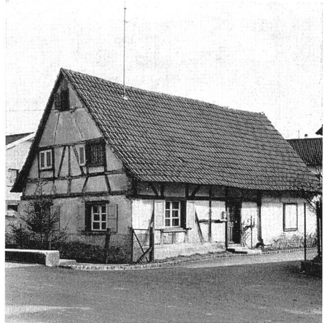
Abb. 40 Kleinhaus mit nachträglicher Erweiterung rechts (vgl. Grundriss, Abb. 43). Das Haus besitzt keinen Keller, die Schwellen liegen auf einem niedrigen Mauersockel. Steinbrunn-le-Haut F. Vgl. Querschnitt Abb. 15.
