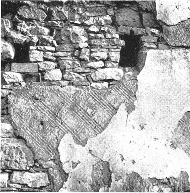
Abb. 29 Unregelmässige Kalkblöcke am Mauerwerk eines Waschhauses. Der Verputz besteht aus einem Lehmaufstrich, der das eingekerbte Rautenmuster zeigt und mit heller Kalkmilch überstrichen ist. Steinbrunn-le-Haut F.
