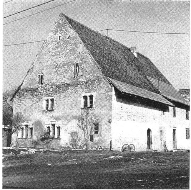
Abb. 30 Sog. «Gerichtshaus», massiver Bau mit gotischen Türen und Fenstern. Lutter F (1542).
