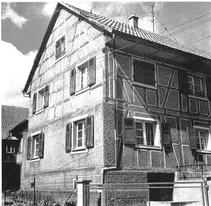
Abb. 10 Fachwerkhaus mit giebelseitig vorgesetzter Vermentelung des Fachwerkes im Erdgeschoss. Attenschwiller F.
