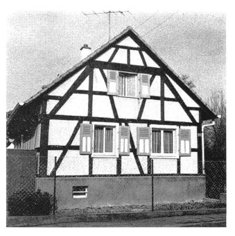
Abb. 28 Der Kniestock ermöglicht nachträglich eine flachere Dachneigung. Steinbrunn-le-Haut F.
