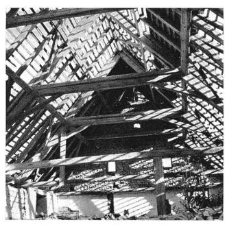
Abb. 25 Sparrendach in abbruchreifem Bauernhaus. Der Dachboden ist bereits eingerissen. Kilchberg BL.
