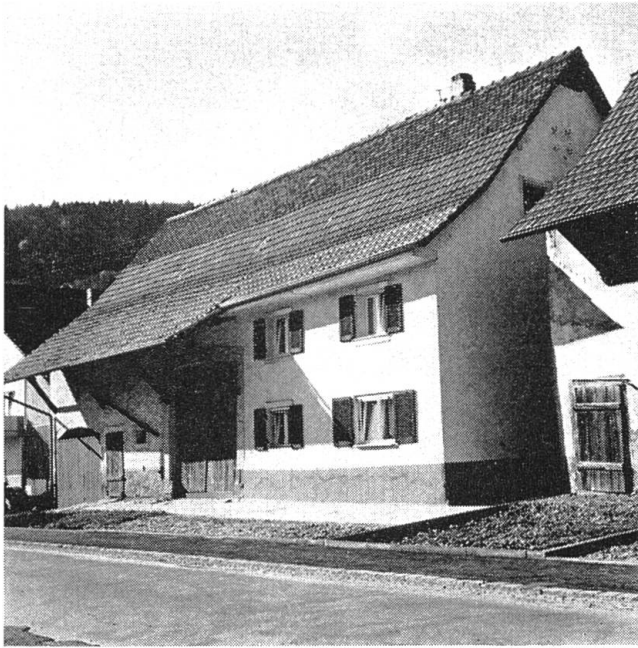
Abb. 49 Sekundärer Vielzweckbau, Wirtschaftsteil mit Tenn, Stall und Futtertenn. Herten D.
