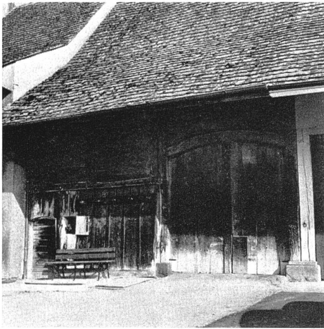
Abb. 6 Ständerbau einer Scheune mit eingesenkten Bohlen unten stehend, oben liegend. Rechts Tennstor. Rüfenberg BL.
