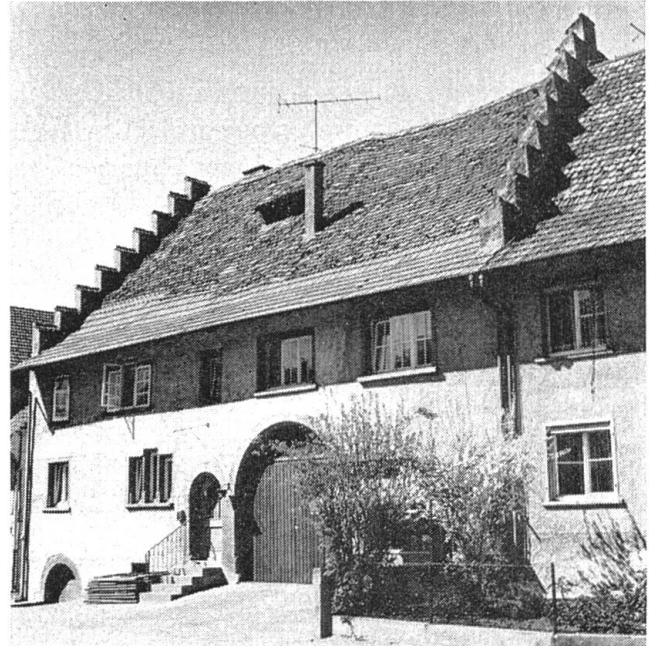
Abb. 50 Sekundärer Vielzweckbau mit Treppengiebel, alter Meierhof, Mittertennhaus. Scheunenteil nachträglich ausgebaut (Wohnräume, Laden). Inzlingen D (1580).
