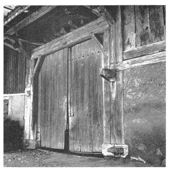
Abb. 18 Beidseits des Tenntors ragen die Köpfe der überkämmten Ankerbalken vor, die Schwelle ist durchgezapft und mit einem Holznagel gesichert. Böckten BL.
