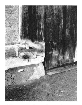
Abb. 11 Durchgezapfte und mit Holznagel gesicherte Schwelle einer Scheune. Wentzwiller F.
