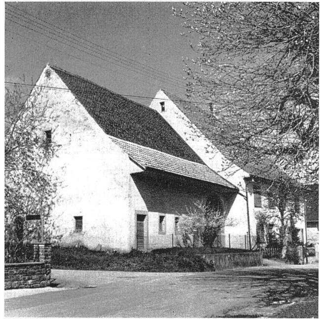
Abb. 36 Sekundärer Vielzweckbau, bestehend aus Wohn- und Wirtschaftsteil, konstruktive Trennung der in derselben Firstrichtung laufenden Baukörper. Scheune mit zwei Ställen und einem Tenn. Nollingen D.
