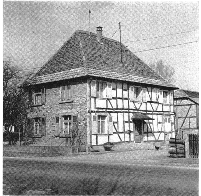
Abb. 23 Auf grossen Wohnhäusern ist nicht selten ein Walmdach aufgesetzt, das aber Sparrenkonstruktion aufweist. Blotzheim F.
