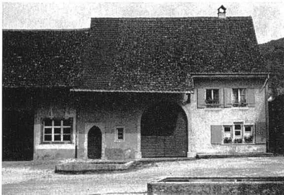
Abb. 37 Sekundärer Vielzweckbau ohne äussere Trennung von Wohn- und Wirtschaftsteil, sog. Mittertennhaus. Muttentz BL.
