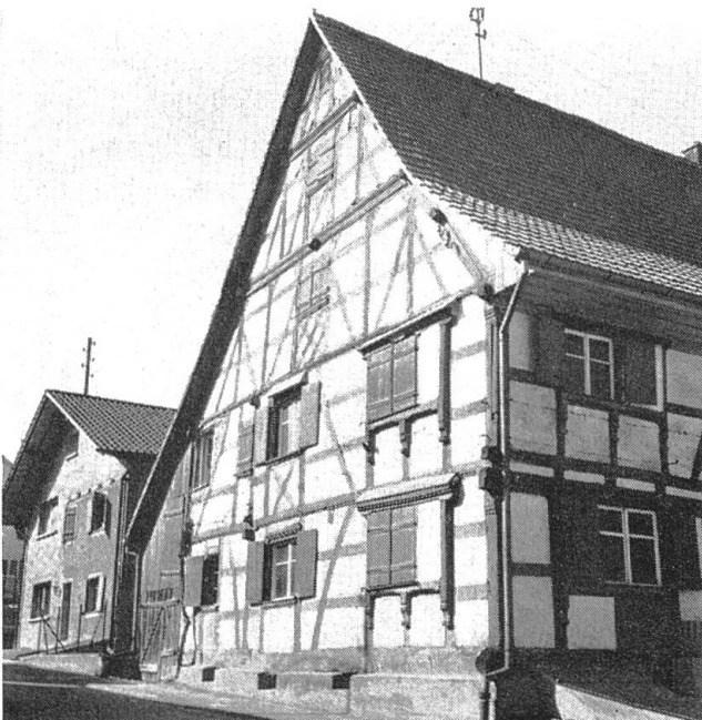
Abb. 20 Stockwerkweise abgebundenes Fachwerk (deutlich sichtbar an der Hausecke) aus dem späten 17. Jh. Buschwiller F (1688).
