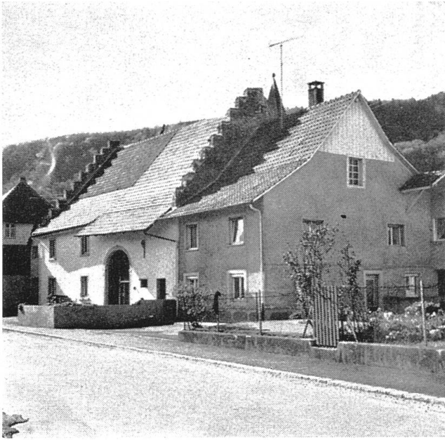
Abb. 27 Sparrendächer weisen häufig einen Knick auf, der erlaubt, die Dachfläche stärker über die Traufwand hinauszuziehen. Hier noch ein Haus mit Treppengiebel. Herten D.
