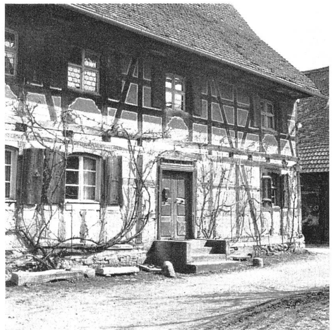
Abb. 21 Charakteristisches Fachwerk des 19. Jh. Knoeringen F (1803).
