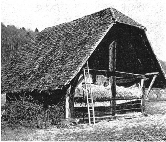
Abb.1 Einfacher Ständerbau mit Firstsäule bei einem Heuschober. Hölstein BL (1678).
