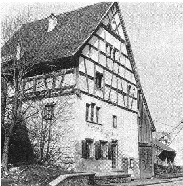
Abb. 51 Gestelztes Haus, im Untergeschoss Stall und Werkstatt. Gekuppelte gotische Fenster deuten die Lage der Stube im Obergeschoss an. Auf den Massivsockel ist ein Fachwerk aufgesetzt. Raedersdorf F.
