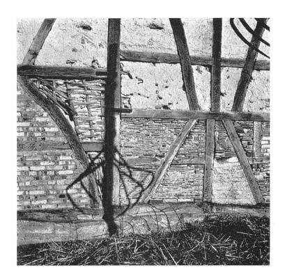
Abb. 9 Fachwerkwand einer Scheune mit verschiedenen Materialien als Gefachfüllung: Backsteine, Flechtwerk mit Lehmwerstrich, Ziegel mit Lehmmörtel. Wentzwiller F.
