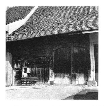
Abb. 6 Ständerbau einer Scheune mit eingenuteten Bohlen unten stehend, oben liegend. Rechts Tenntor. Rünenberg BL.
