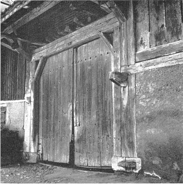
Abb. 18 Beidseits des Tenntors ragen die Köpfe der überkämmt Ankerbalken vor, die Schwelle ist durchgezapft und mit einem Holznagel gesichert. Böckten BL.
