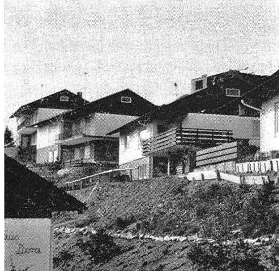
Abb. 8 Ein- und Zweifamilienhäuser, ein Hotel mit Einkaufs-Center und ein Schwimmbad sind für das Feriendorf Wies-Stockmatt geplant. Das Bild zeigt einige der fertiggestellten Ferienhäuser. · Fig. 8 Des maisons monofamiliales ou mitoyennes, un Hôtel avec centre commercial et une piscine sont programmés au village de vacances de Wies-Stockmatt. La photo montre quelques-unes des maisons de vacances déjà achevées.
