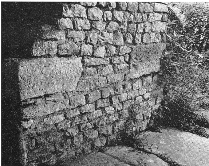
Abb. 6 Römische Badruine Badenweiler. Ausgang aus der westlichsten Piscine Cw in den Vorraum Fw, von innen nach Westen gesehen. Mauerwerk aus Handquadern von Hauptrogenstein ohne Putz. Kantenverstärkung durch grosse, gespitzte Quader aus Buntsandstein (Bauperiode I nach Mylius ). Türschwelle aus Buntsandsteinplatten.
