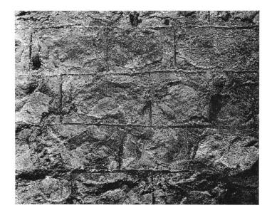
Abb. 11 Römische Badruine Badenweiler. Typische Mauerverblendung aus Handquadern von Hauptrogenstein mit Fugenritzung im Mörtel: opus vittatum. NW Stützpfeiler der westlichen Piscine Cw (Bauperiode IIa nach Mylius).
