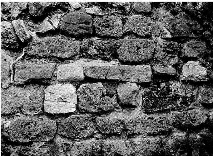
Abb. 19 Burgruine Badenweiler. SE Innenmauer des Palas. Viele Tuffsteinquader angesägt auf der Sichtfläche (X).
