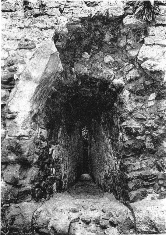
Abb. 21 Burgruine Badenweiler. Palas mittleres Scharfenfenster. Tuffsteingewölbe in der 3,2 m dicken Mauer. Links Reste der Türverblendung aus Buntsandstein (Basisquader und schräg ins Gewölbe gestellter Block) und oligozänem Konglomerat.
