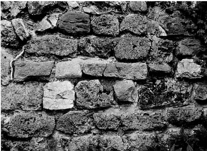
Abb. 19 Burgruine Badenweiler. SE Innenmauer des Palas. Viele Tuffsteinquader angesägt auf der Sichtfläche (×).
