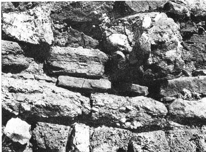
Abb. 15 Burgruine Badenweiler. SE Aussenmauer des Palas. Material: grobes unteroligozänes Konglomerat, Kalksandstein, Tuffquader (zum Teil angesägt), je ein Buntsandstein- und Quarzriffblock. Vgl. Abb. 14. Die lange Kalksandsteinplatte in Bildmitte misst 52 \times 5 cm.
