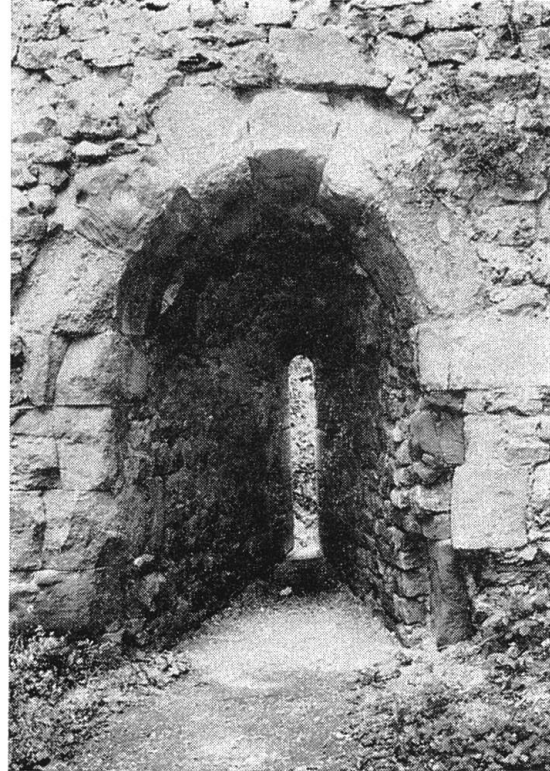
Abb. 21 Burgruine Badenweiler. Palas mittleres Scharfenfenster. Tuffsteingewölbe in der 3,2 m dicken Mauer. Links Reste der Türverblendung aus Buntsandstein (Basisquader und schräg ins Gewölbe gestellter Block) und oligozänem Konglomerat.
