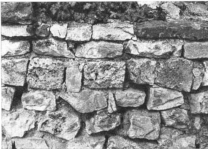
Abb. 10 Römische Badruine Badenweiler. Verblendmauerwerk der Ostmauer der östlichen Piscine Co (Bauperiode Ia nach Mylius). Mindestens die obersten vier Schichten mit Buntsandstein, oligozänem Kalksandstein und Konglomerat, mit Tuffquadern und einem Mörtel mit Schlackensplitt sind restauriert. Vom linken Tuffquader bis zur links folgenden Türleibung sind es 1,35 m.
