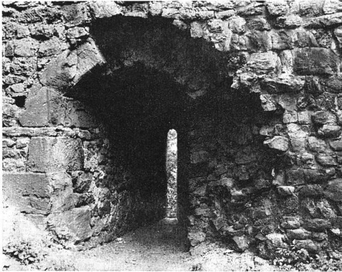
Abb. 20 Burgruine Badenweiler. Palas SW Schartenfenster. Türverblendung (links) aus Läufern und Bindern von Buntsandstein und oligozänem Kalksandstein bzw. Konglomerat.
