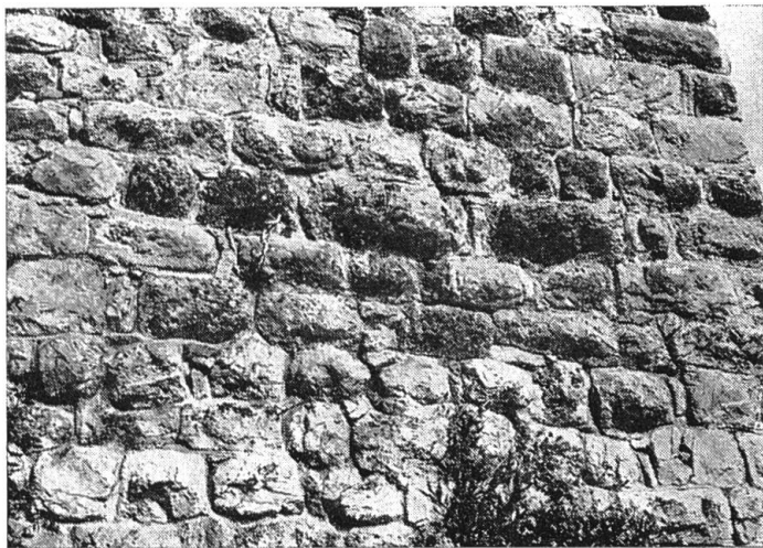
Abb. 16 Burgruine Badenweiler. Südöstliche Mauer von C. Struktur einer Mauer aus viel grobem Quarzriffmaterial, Hauptrogenstein und Kalksandstein. An der NE Mauerkante einige Quader gesäumt.
