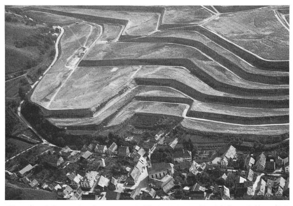
Abb. 3 Ausschnitt aus dem Grossterrassen-Rebflurbereinigungsgebiet Schelingen-Rebberg (Kaiserstuhl). Etwa gleiches Gebiet wie Abb. 2. Zustand September 1967 nach der Beendigung der Terrassenschub- und Planierungsarbeiten, jedoch vor dem neuen Rebenaufbau. Man beachte die geometrische Linienführung der durchgehenden neuen Grossterrassen mit Böschungshöhen zwischen 6 und 12 m. (Luftbild W. H. Friese. Freigegeben v. Reg.-Präs. Südbaden, Nr. P 585—67.)
