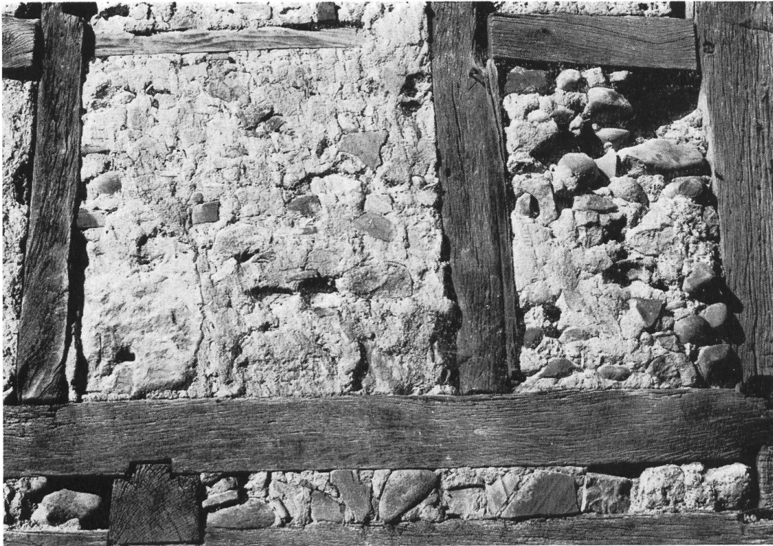
Abb. 8 Eimeldingen. Im Winkel 3, Südwand. Fachwerk mit bunten (alpinen) Geröllen aus Schottern des Rheins.
