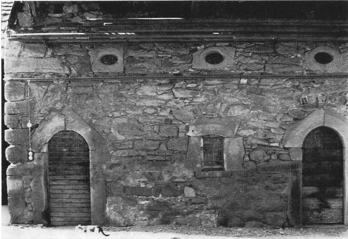
Abb. 19 Binzen. Hauptstrasse 38, Wirtschaftsgebäude von 1805. (Jahrzahl auf Scheuertor). Ausbaustil (bäuerlicher Klassizismus) in primitiver Ausführung. — Werkstein: oligozäner Kalksandstein (Fensterbank Buntsandstein). — Mauerwerk: überwiegend Kalksandstein, dazu Tüllinger Kalkstein. Eckquader ebenfalls Kalksandstein (links = Osten), bereits stark korrodiert (also schlechte Qualität). Ziegelbruch.
