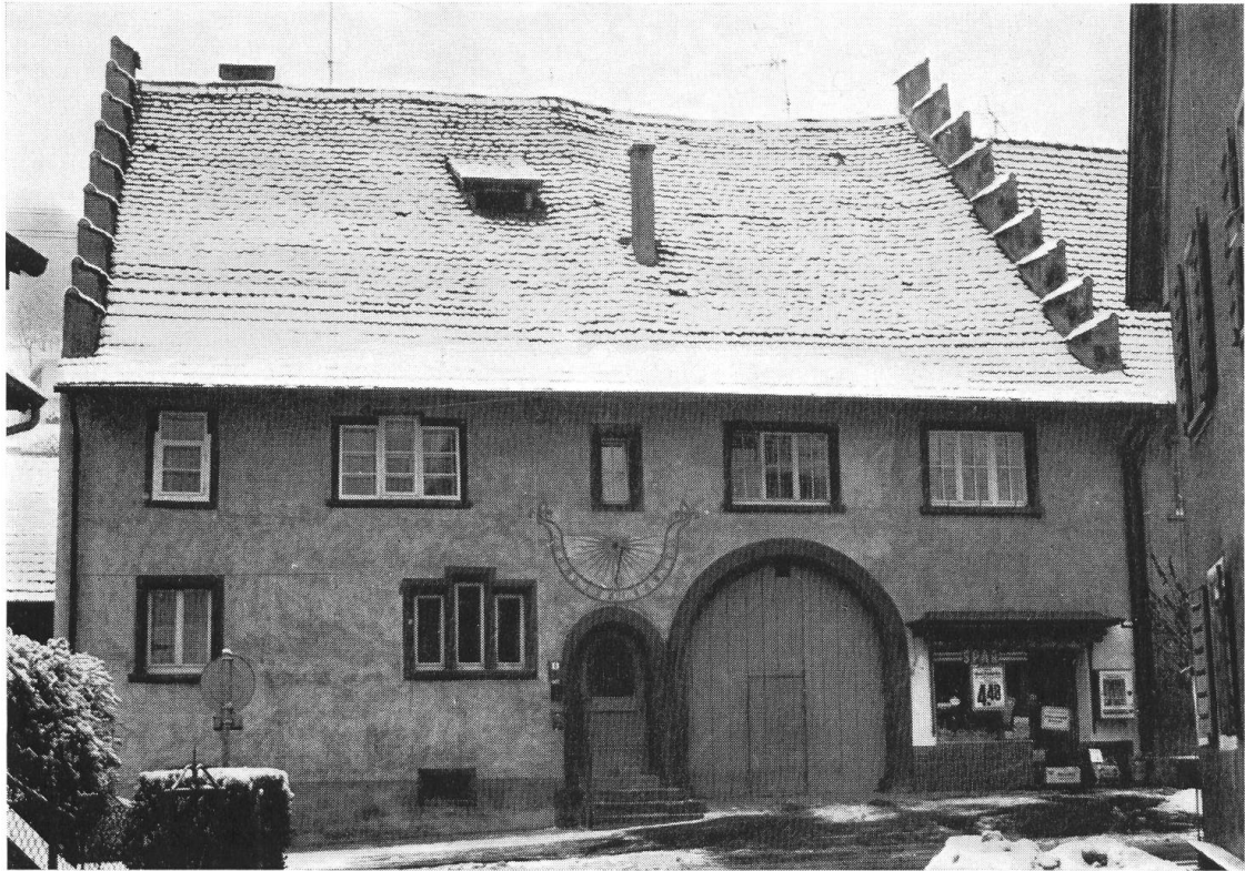
Abb. 10 Inzlingen. Riehenstrasse 8. Alter Meierhof 1580. Gotisches Haus mit typischem Staffelgiebel, mit gekuppelten Fenstern, Rundbogen an Türen und Scheuertor. Werkstein: Buntsandstein.
