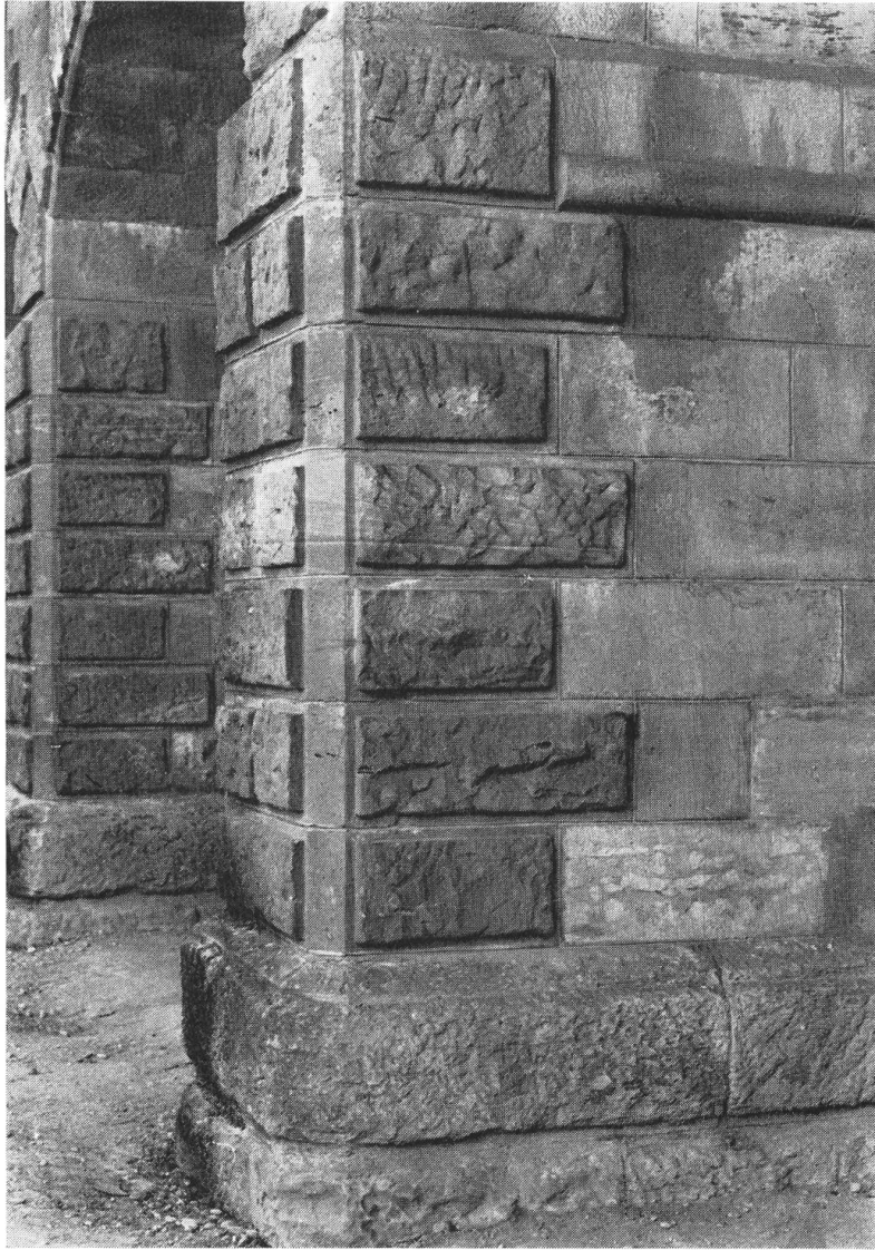
Abb. 11 Bellingen. Eisenbahnbrücke («Bogenstellung») von 1847—1848. Pfeiler der Brücke von Westen gesehen.
