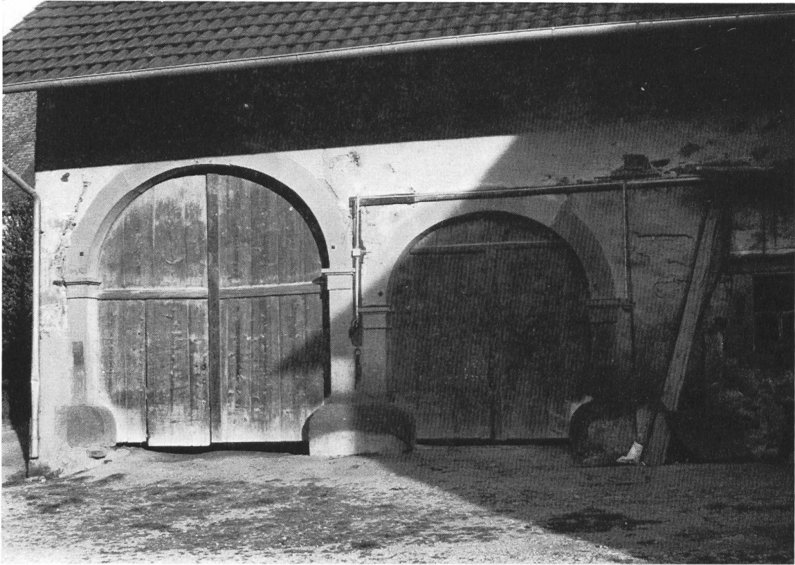
Abb. 17 Wollbach. Haus 45, Wirtschaftsgebäude von 1838. Ausbaustil (bäuerlicher «Weinbrennerstil»). Werkstein: Buntsandstein. Ansichtsseite (gegen Süden). Man beachte: die grossen Sockelsteine der Torpfosten, kubische Kämpfer unter dem Bogenansatz, ovale Oberlichtfenster (im Bild im Schatten der Dachtraufe), «1838» in einer Kartusche mit (noch barockem) Muschelmuster in den abgesprengten Ecken.
