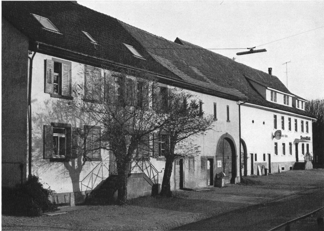
Abb. 18 Haagen. Hauingerstrasse 43 und 45 («Krone»). Das Haus 43 ist 1804 erbaut. Schauseite (Traufseite). Werkstein: Buntsandstein. Bäuerlicher Weinbrenner-Stil (Klassizismus). Man beachte: die spiegelbildliche Anordnung der Bauelemente (Türen mit doppelläufiger Freitreppe, Fenster, Oberlichter, Scheunentore) in beiden Häusern. Verschieden ist nur die Anzahl der Fensterachsen (in Haus 43 fünf, in Haus 45 sechs Achsen) und die Form der Oberlichtfenster (in Haus 43 schlitzförmig, in Haus 45 oval). Die beiden Häuser sind leicht gegeneinander versetzt. Die Dacheinbauten sind aus unserer Zeit.
