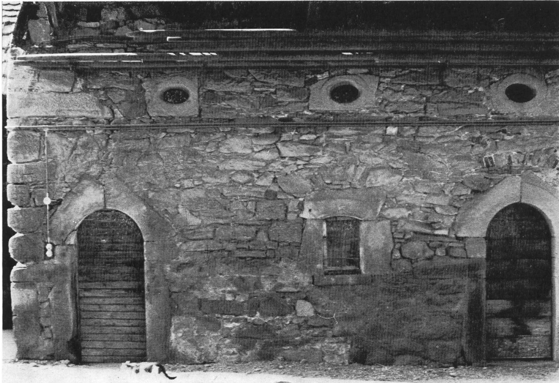
Abb. 19 Binzen. Hauptstrasse 38, Wirtschaftsgebäude von 1805. (Jahrzahl auf Scheuertor). Ausbaustil (bäuerlicher Klassizismus) in primitiver Ausführung. — Werkstein: oligozäner Kalksandstein (Fensterbank Buntsandstein). — Mauerwerk: überwiegend Kalksandstein, dazu Tüllinger Kalkstein. Eckquader ebenfalls Kalksandstein (links = Osten), bereits stark korrodiert (also schlechte Qualität). Ziegelbruch.
