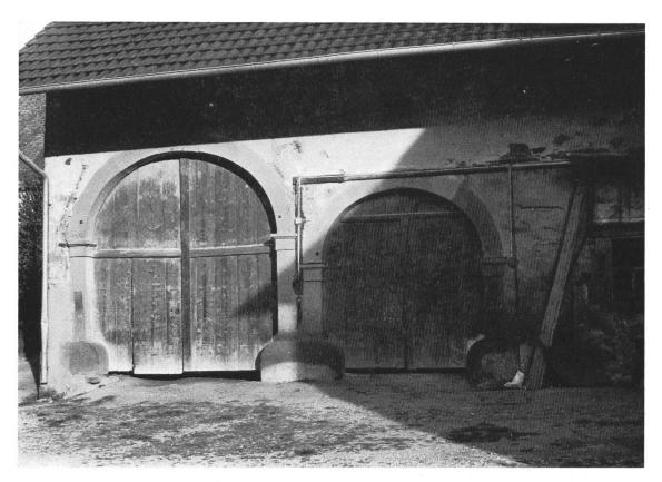
Abb. 17 Wollbach. Haus 45, Wirtschaftsgebäude von 1838. Ausbaustil (bäuerlicher «Weinbrennerstil»). Werkstein: Buntsandstein. Ansichtsseite (gegen Süden). Man beachte: die grossen Sockelsteine der Torpfosten, kubische Kämpfer unter dem Bogenansatz, ovale Oberlichtfenster (im Bild im Schatten der Dachtraufe), «1838» in einer Kartusche mit (noch barockem) Muschelmuster in den abgesprengten Ecken.
