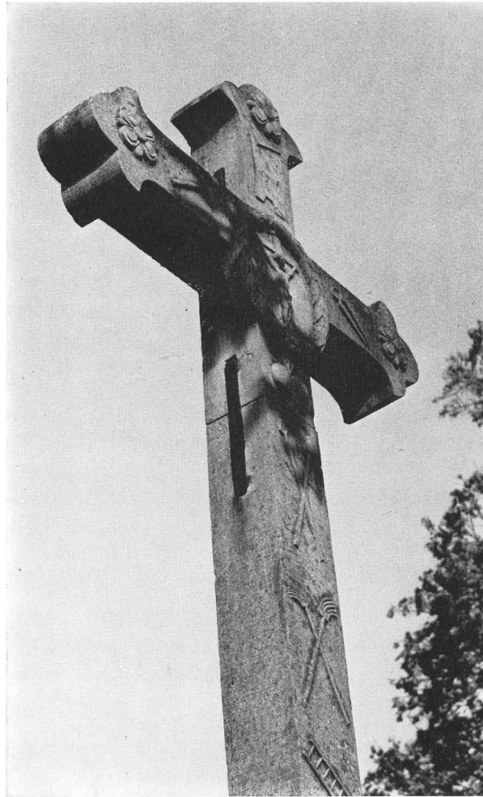
Abb. 4 Rheinweiler. Crucifixus in der Rothberger Strasse. 1823. Beispiel für die bildhauerische Verwendung des unteroligozänen Kalksandsteines. Die einzelnen Kalksandsteinquader sind horizontal scharriert und durch Eisenklammern zusammengehalten. In Flachrelief auf der Stele die Marterwerkzeuge, darunter (auf dem Bild nicht mehr zu sehen) die Inschrift: ES IST VOLLBRACHT JOH · 19 C 30 : V : 1823
