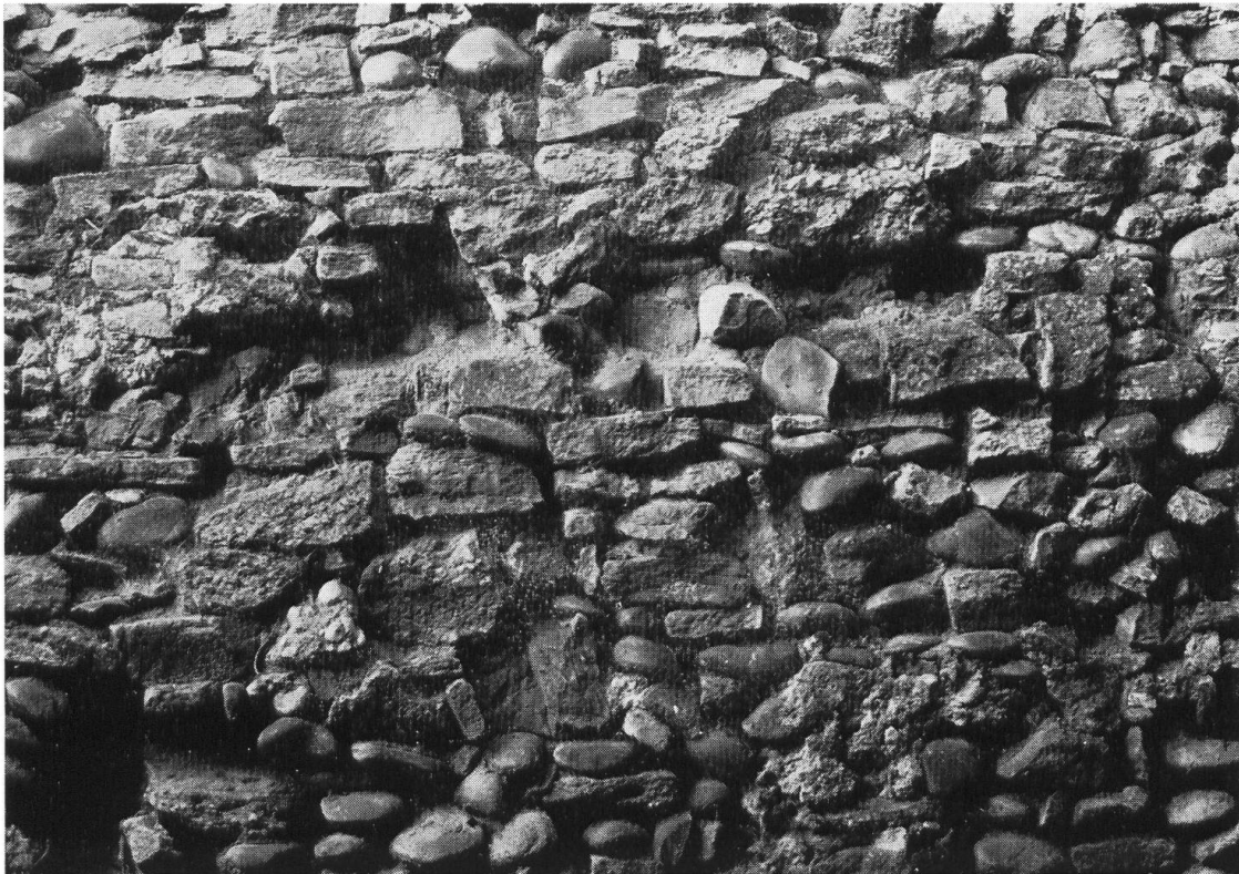
Abb. 9 Bellingen. Kirchstrasse 7, Scheune von 1783. Ostmauer (gegen die Eisenbahnbrücke hin). Struktur eines Mauerwerks aus vielen Rheingeröllen, aus Kalksandstein und Konglomeraten des Unteroligozäns.
