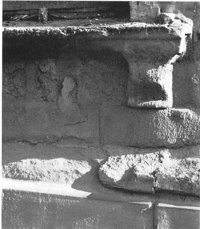
Abb. 15 Lörrach. Villa KBC, Baslerstr. 135. Baujahr 1864. Korrosion am Werkstein: Molassesandstein (Berner Sand- stein). Stark korrodierte Fenster- bank in Westexposition. Quader im aufgehenden Mauerwerk gehen bereits zu Bruch.
