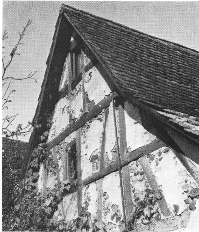
Abb. 7 Egisholz. Haus 9, Südgiebel. Fachwerk mit Buntsandstein- geröllen in den Gefachen, Gerölle aus altpleistozänen Schottern und dazu Ziegelbruch.
