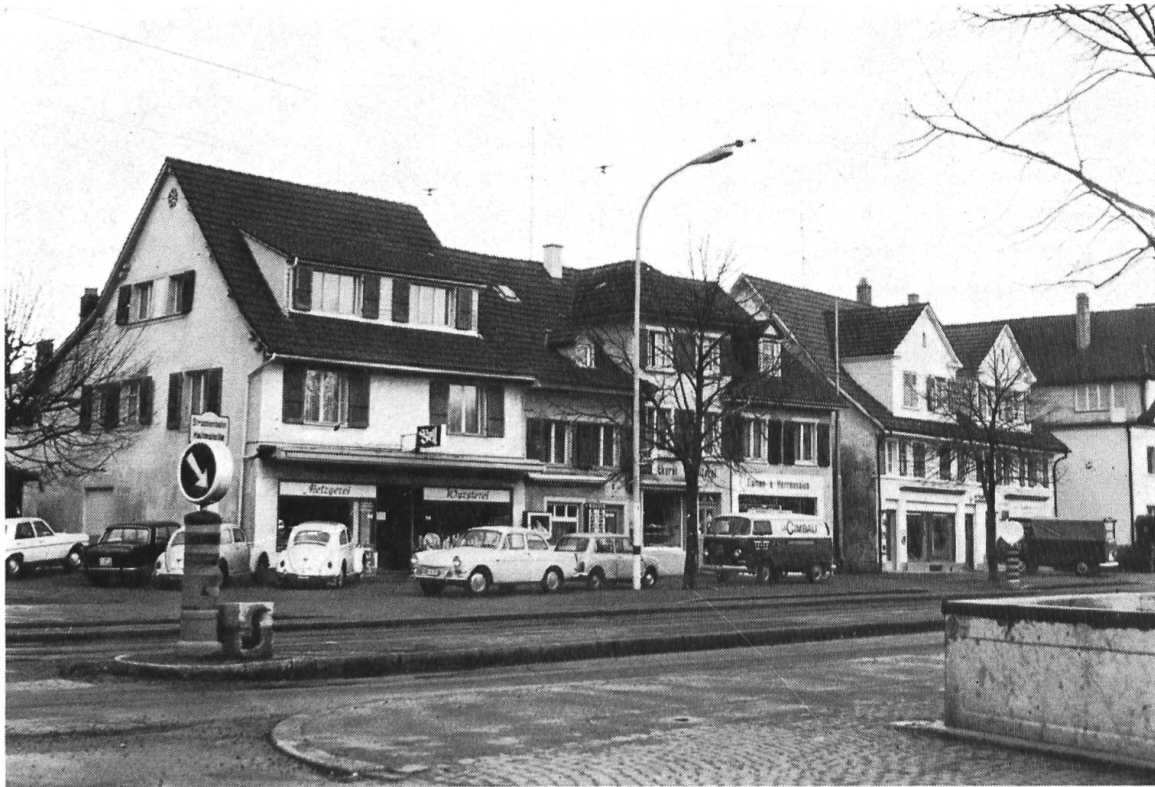
Abb. 4 Die einzige geschlossene Häuserzeile des alten Dorfes mit Gebäuden, die nicht agrarischen Ursprungs sind.
