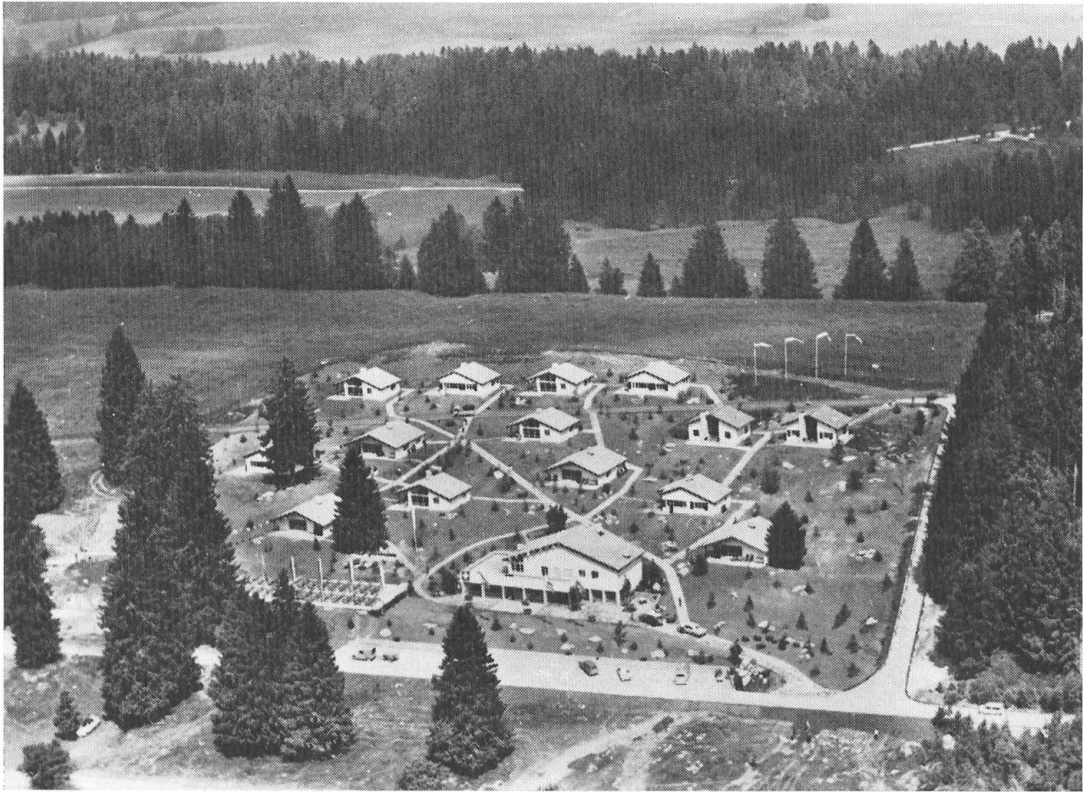
Abb. 1 Das Feriendorf der Schweizer Reisekasse in Montfaucon von SE. Im Vordergrund das Empfangsgebäude mit dem Hallenbad.
