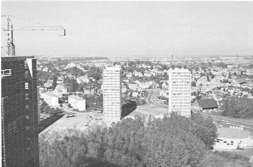
Fig. 2 L'impression d'écrasement du voisinage est atténué par l'espacement des immeubles, l'importance des espaces verts avec arbres, arbustes et pelouses, et par la situation au fond d'un vallon, dominé ici par la colline du Geisberg de Dornach. De larges voies de circulation relient la Z. U. P. à la ville: le boulevard des Nations débouche au centre sur le boulevard de Paris. En bas, à droite des peupliers, le magasin «Sunac».
