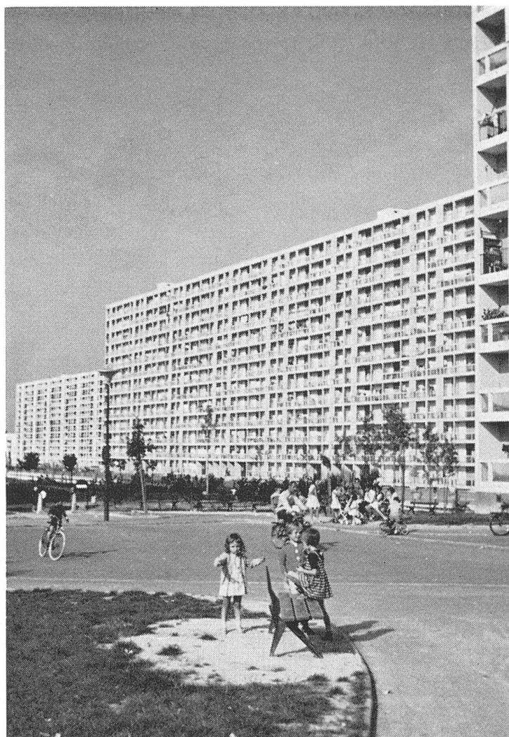
Fig. 5 Façades, côté séjour, à loggias-galeries; l'espacement entre les bâtiments donne un coefficient d'aération de 32 \text{ m}^3 , élevé compte tenu de la densité de population.
