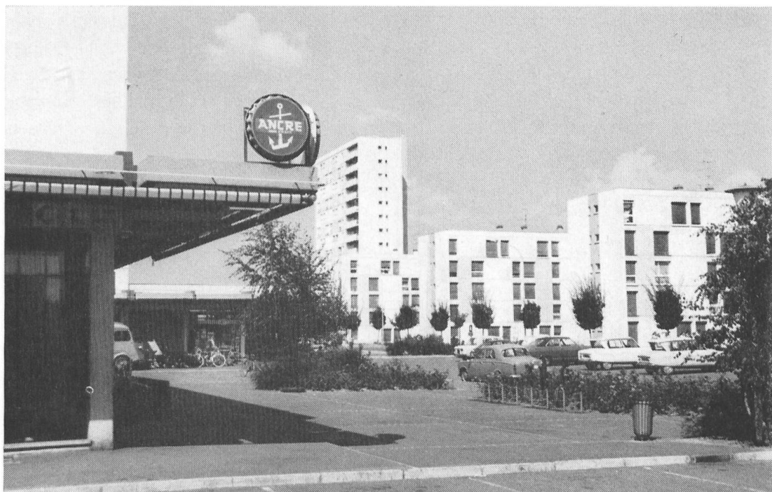
Abb. 7 Die Z. U. P. von Colmar, ein wohlgelungenes Beispiel moderner Planung am Westrande der Stadt. Die Baukuben sind in der Höhe differenziert, mit genügenden Grünflächen umgeben und durch ein Einkaufszentrum ergänzt.
