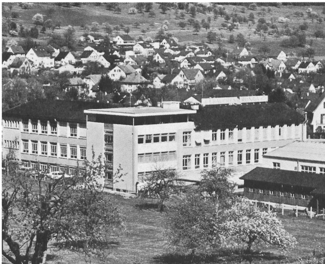
Abb. 1 Lausen und Ronda AG von SW. Man erkennt rechts die in Gang gekommenen Erweiterungen der Fabrik; im Hintergrund die am Südhang über der Ergolz empor-kletternden Einfamilienhäuser, sichtbarstes Zeichen eines Industriedorfes und der Wohlstand verbreitenden Konjunktur.
