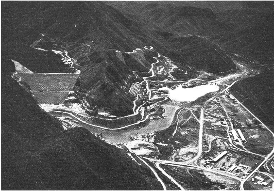
Abb. 2 Infiernillo: Luftaufnahme der gesamten Anlage während des Baus. Der Stausee ist gefüllt; der Überlauf schiesst in das Flussbett unterhalb der Umspann-Plattformen. Das Maschinenhaus befindet sich in dem Bergzug zwischen Damm und Flussbett, auf der Seite des Staates Guerrero. Das Baulager wurde auf der Seite des Staates Michoacán errichtet.
