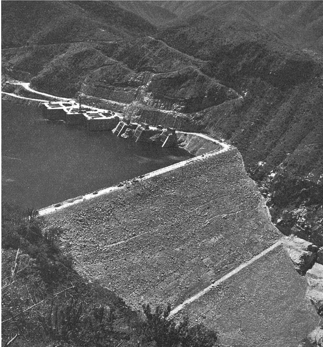
Abb. 3 Infiernillo: Blick auf die Talsperre mit den je drei Überlauf- und Einlauftoren.
