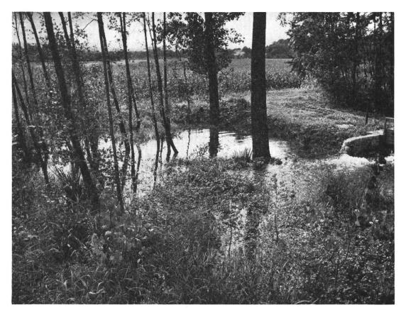
Abb. 3 Wässerstelle Habermatten mit Einlauf des vorfiltrierten Rheinwassers
