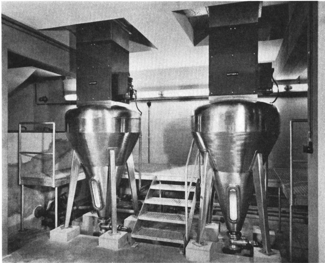
Abb. 6 Trockendosierer und Sättiger für die Herstellung der Fluorlösung
