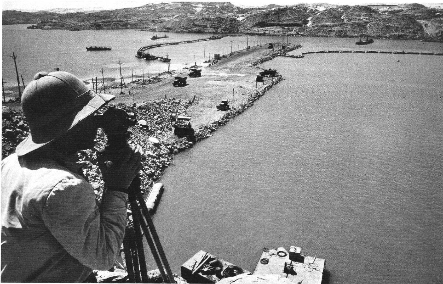
Abb. 4 Der neue Hochdamm von Assuan : Die erste Bauetappe kurz vor dem Abschluss (Mitte März 1964). Im Hintergrund erkennt man den über die Wasseroberfläche emporwachsende Fangdamm; er liegt stromaufwärts und besteht aus Sand und aus dem Aushubmaterial des Umlaufkanals. Photo Dr. G. Gerster, Zürich
