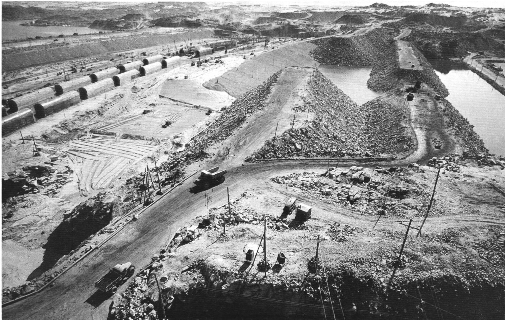
Abb. 5 Der neue Hochdamm von Assuan : Hauptdammkörper und stromoberseitiger Fangdamm sind bereits zusammengewachsen (Stand: 2. Hälfte 1965). Die Inspektionstunnel werden in den Hauptdamm eingebracht. Photo Dr. G. Gerster, Zürich
