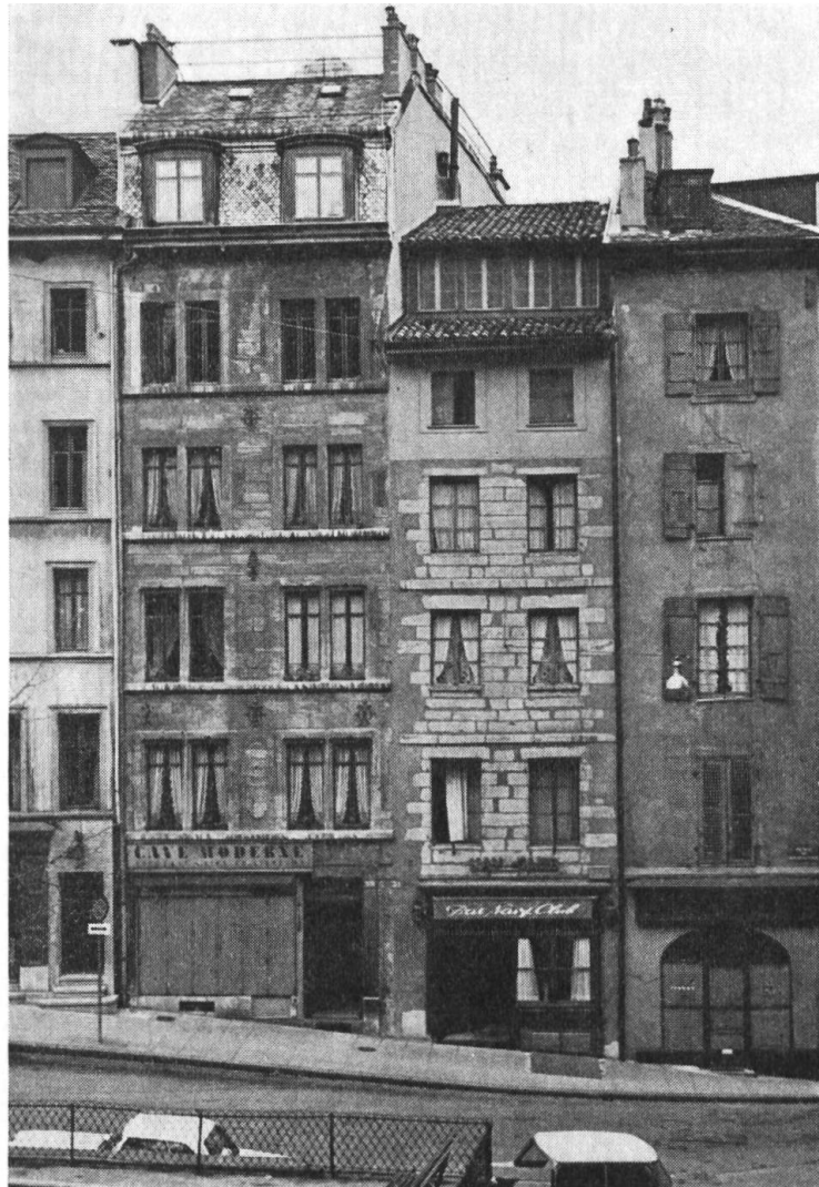
Fig. 9 Place du Bourg de Four, dans le centre administratif.
