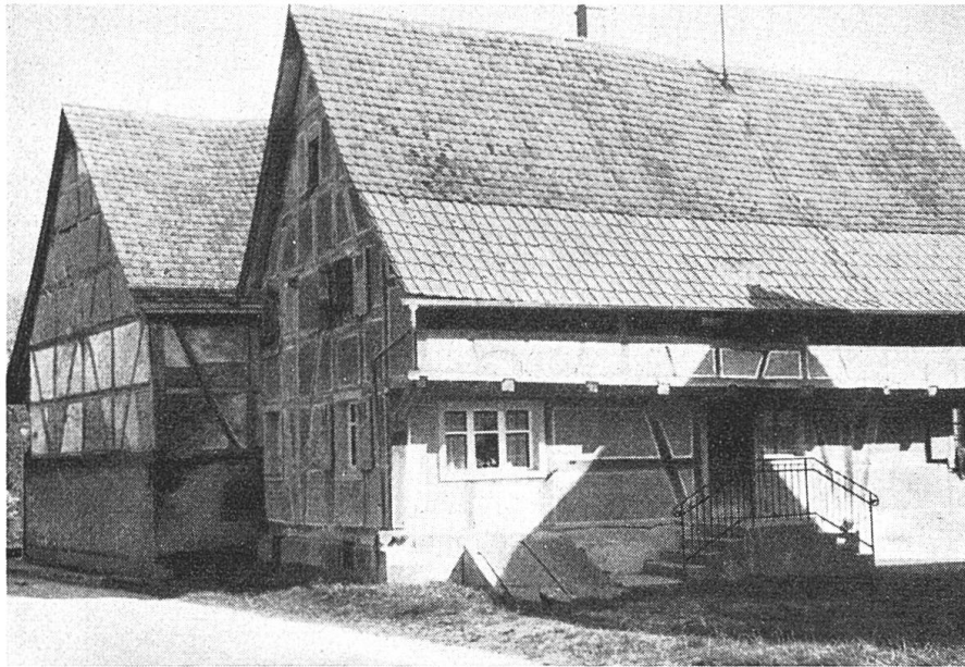
Abb. 1a. Sundgauer Riegelhaus mit Laube (Photo P. Gangloff, 1961).
