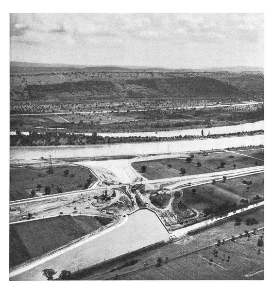
Abb. 2. Schleuse von Niffer im Bau. Man erkennt von hinten nach vorn: Deutsche Autobahn, altes Rheinbett, Grand Canal d'Alsace, Schleuse von Niffer, Hüninger Zweigkanal
