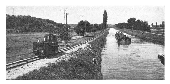
Abb. 1. Hüninger Zweigkanal: Treideltraktor mit Kanalschiff
