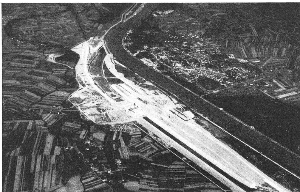
Fig. 4. Le Rhin et le bief de Vogelgrun (Vue aérienne oblique E. d. F.)
