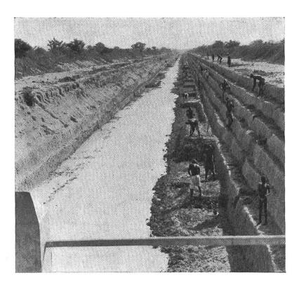
Abb. 4. Bau des Zuleitungskanals zum Meliorationsgebiet von Tamani-Konodimini bei Ségou. Durch seine Arbeit erhält der Afrikaner Anspruch auf eine Parzelle des meliorierten Landes. Photo Service de l'information du Soudan.
