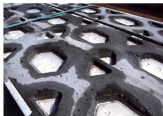
Sonderlösungen bei den Baustoffen, wie etwa der Isolations-Backstein oder die Armierungen der Betonwände mit Glasfaserstäben (oben).
