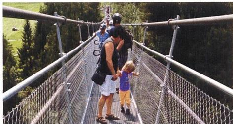
Die Raiffeisen-Hängebrücke Skywalk ist mit Drahtgitter gesichert.
