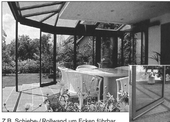
Z.B. Schiebe-/Rollwand um Ecken führbar.
